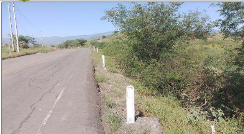
Foto N°17. Dispositivo de Seguridad en regular estado de conservación
