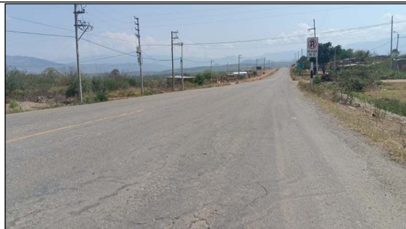
Foto N°02. Vista longitudinal de la vía El Reposo
