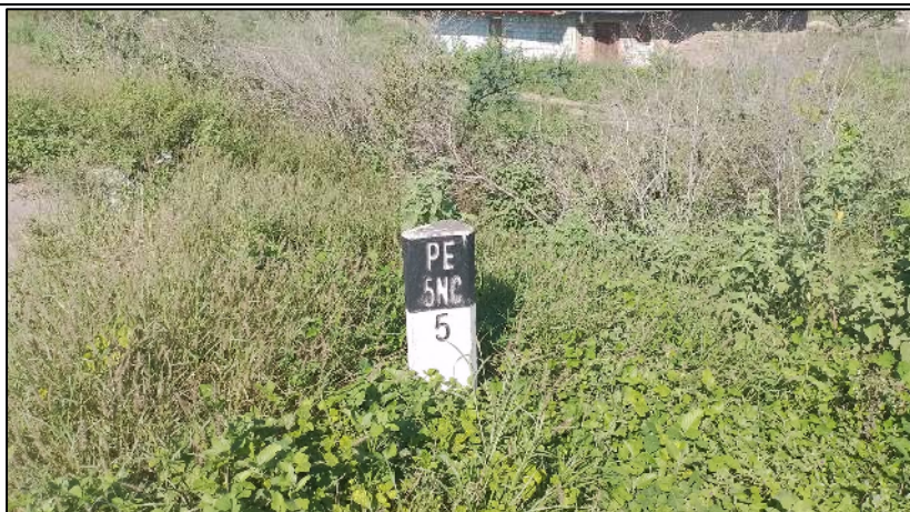
Foto N°15. Hito Kilométrico falto de limpieza y parcialmente oculto
