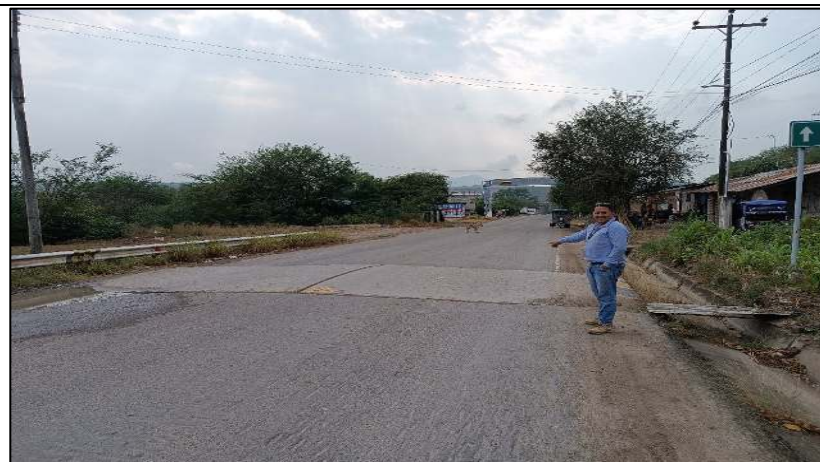
Foto N°20. Reductor de Velocidad Tipo Resalto – Giba en buen estado de conservación sin demarcación
