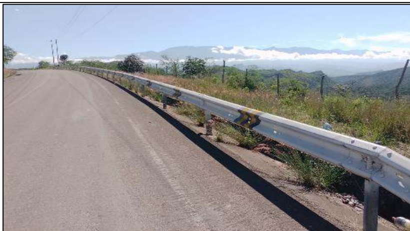
Foto N°19. Guardavía metálico en buen estado de conservación
