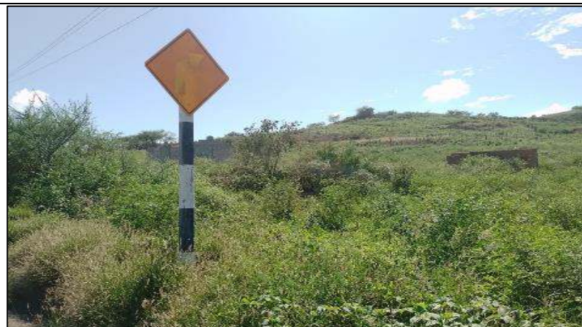
Foto N°08. Señal P-2A poco visible en mal estado de conservación
