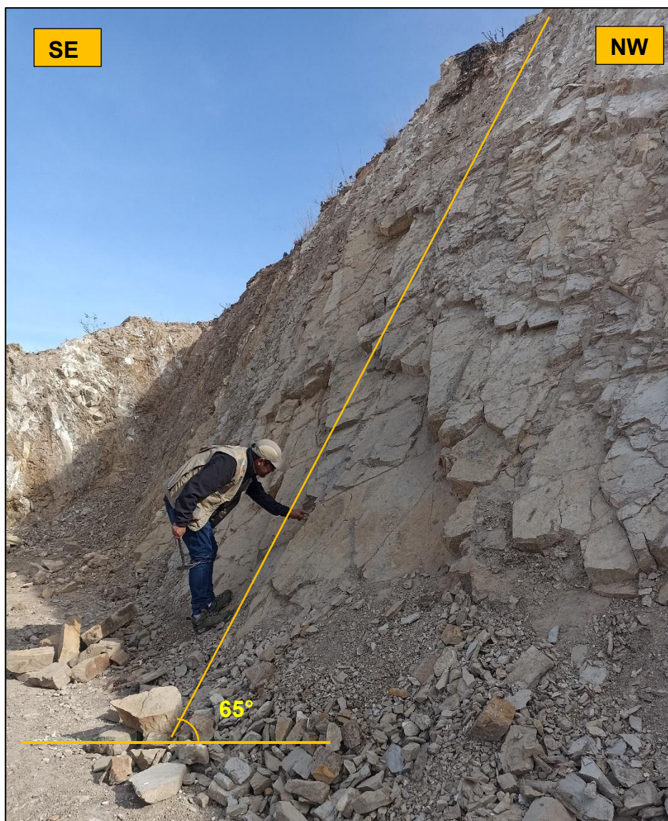
Foto 3.15: Perfil del talud en la progresiva Km 5 + 400
