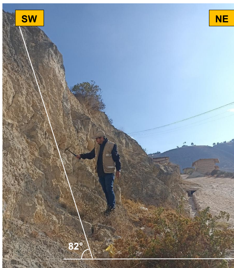
Foto 3.14: Perfil del talud en la progresiva Km 1 + 200
