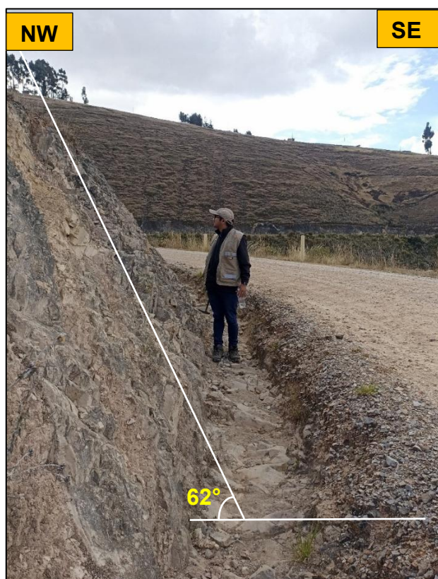
Foto 3.18: Perfil del talud en la progresiva Km 6 + 350.
