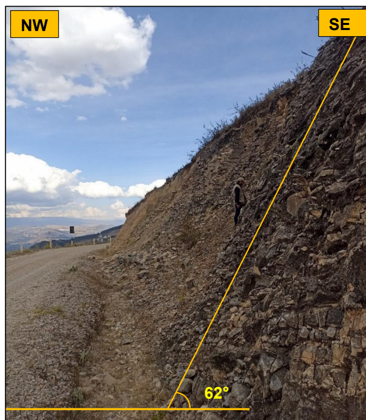
Foto 3.19: Perfil del talud en la progresiva Km 6 + 500.
