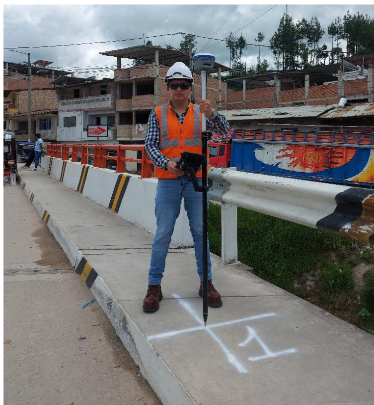
Fotografía 6. Marcado y toma de punto de apoyo - inicio del tramo Chota Bambamarca
