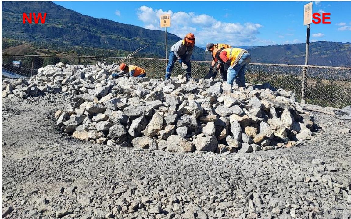
Figura 9: Llenado de los hornos para la calcinación de la roca caliza según estándares, rango de 15 a 30 centímetros, en la calera “Bendición de Dios”.
