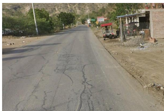
Fotografía. 5 Tramo sin cuentas Km 00+440 – Km 00+606.
