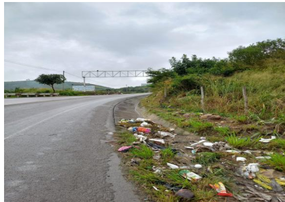
Fotografía. 7 Tramo de cunetas del Km 12+675 – Km 13+011
