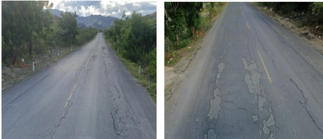
Fotografía. 6 Tramo sin cuentas Km 02+878 – Km 04+164.
