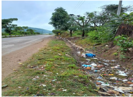
Fotografía. 8 Tramo de cunetas del Km 13+456 – Km 13+504
