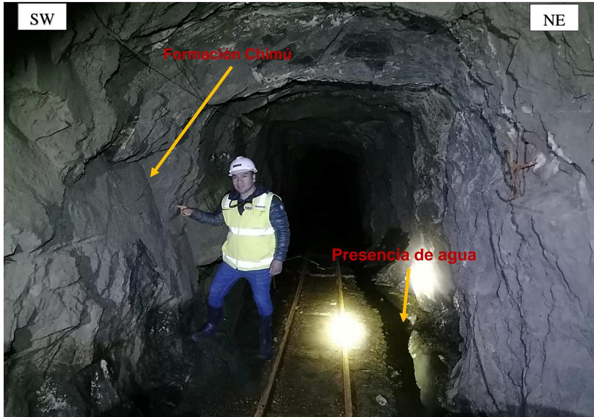
Figura 3.10. Galería del sector: Norte y Sur – Veta Marina, ubicado Pi + 35.00 m., conformado por areniscas de la Formación Chimú.
