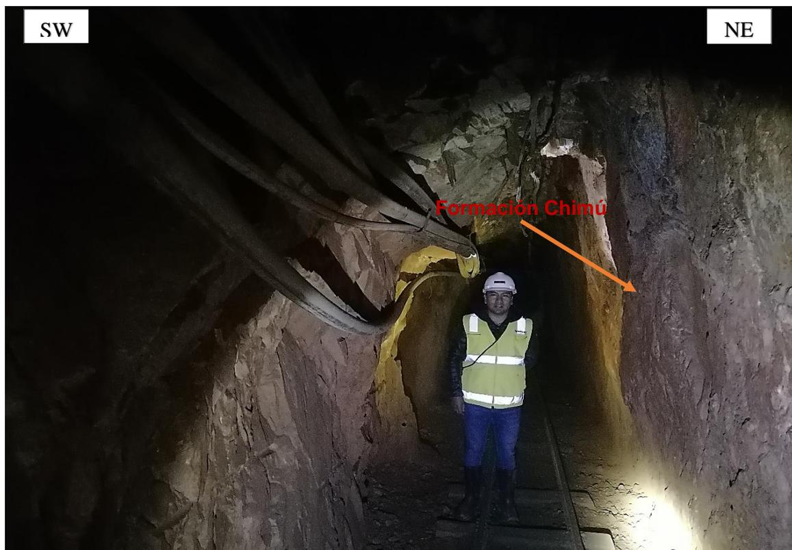
Figura 3.8. Galería del sector: Norte y Sur – Veta Marina, ubicado Pi + 35.00 m., conformado por areniscas de la Formación Chimú.
