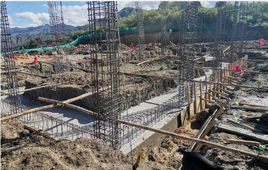
**FOTOGRAFÍA N°11:** Vaciado de concreto de falso piso.
