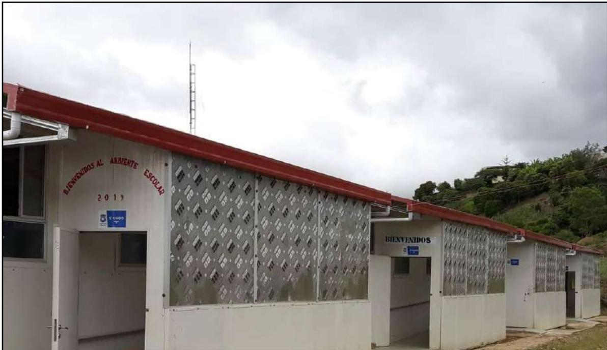
**TOMA 4:** Vista del conjunto de módulos prefabricados y de material metálico, sin una ventilación e iluminación adecuada de la I.E. Tomas Porfirio Gálvez Quispe del C.P Sinchimache
