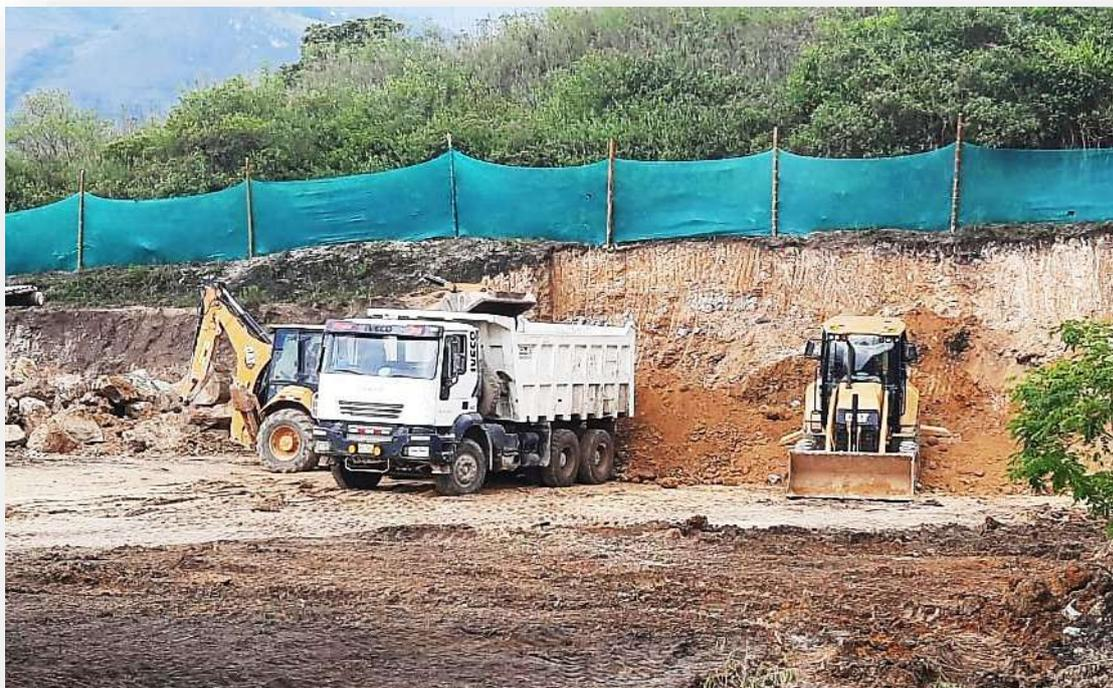
**FOTOGRAFÍA N°09:** Excavación y compactación de subrasante.
