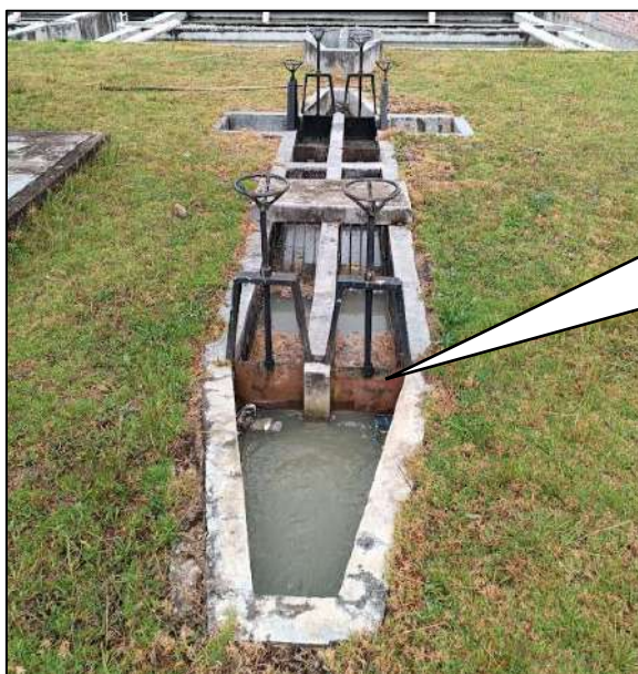
Figura 8: Desarenador N°1 de la PTAR Namora
