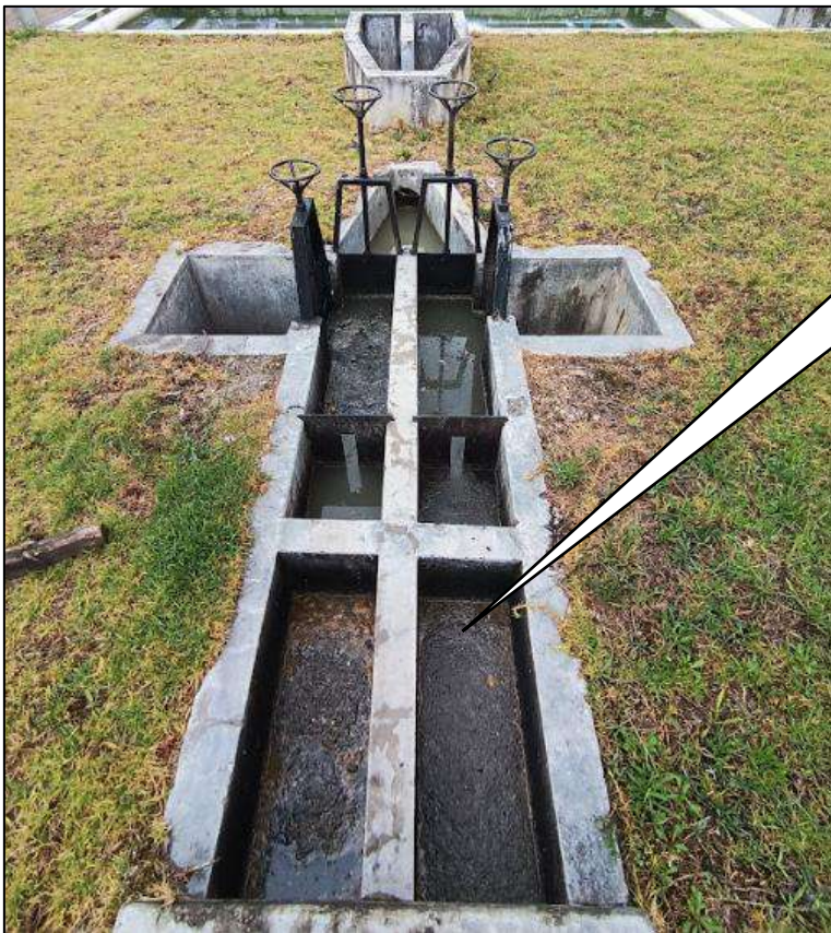
Figura 13: Desarenador N° 2 de la PTAR Namora
