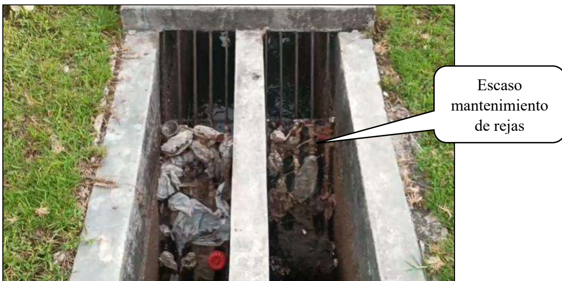
Figura 12: Rejillas de desarenador con PTAR en Mantenimiento
