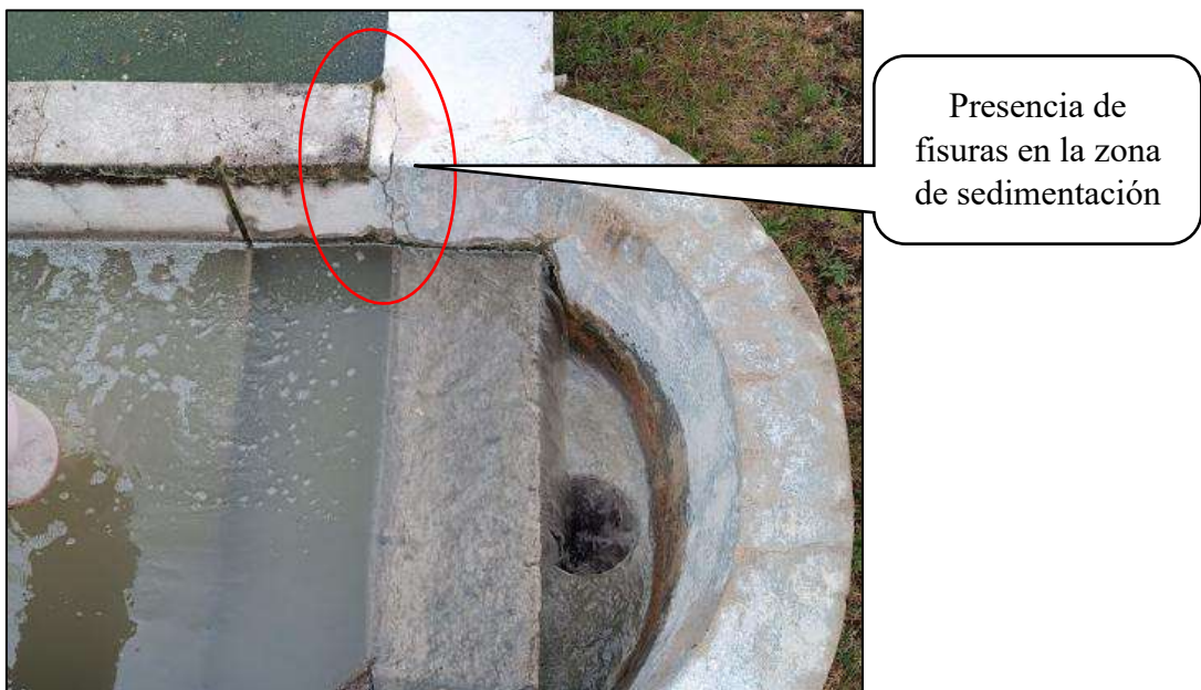
Figura 18: Daños en el Tanque Imhoff N°1
