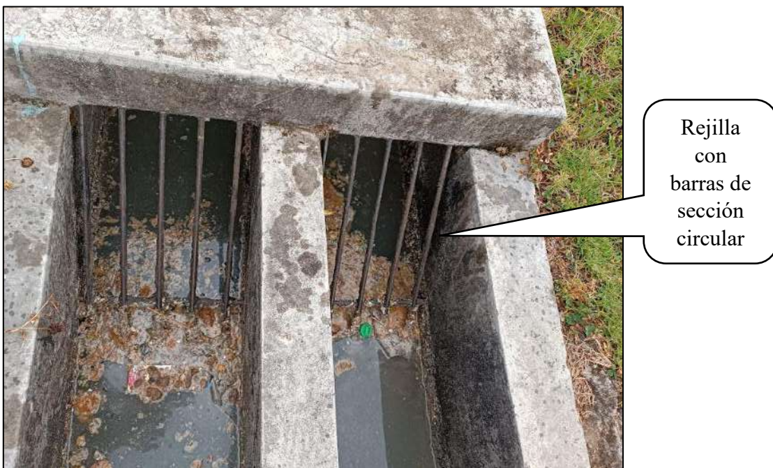
Figura 12: Rejillas de desarenador con PTAR en Mantenimiento
