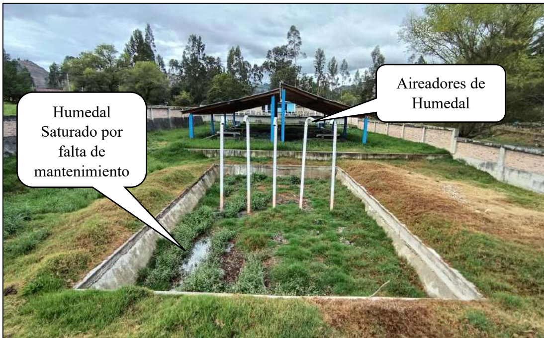
Figura 22: Humedal de Flujo vertical Subsuperficial
