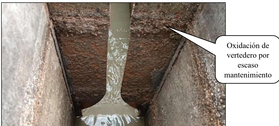
Figura 10: Vertedero tipo sutro cuando el desarenador está en mantenimiento
