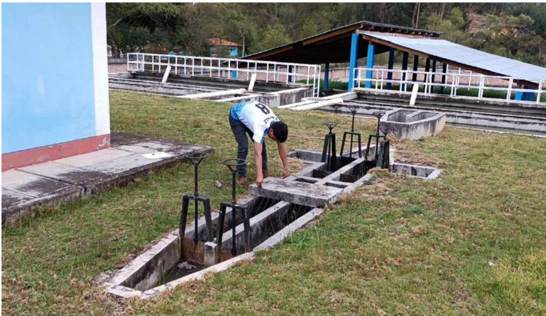
Fotografía N°1. Toma de medidas de las estructuras de la PTAR.
