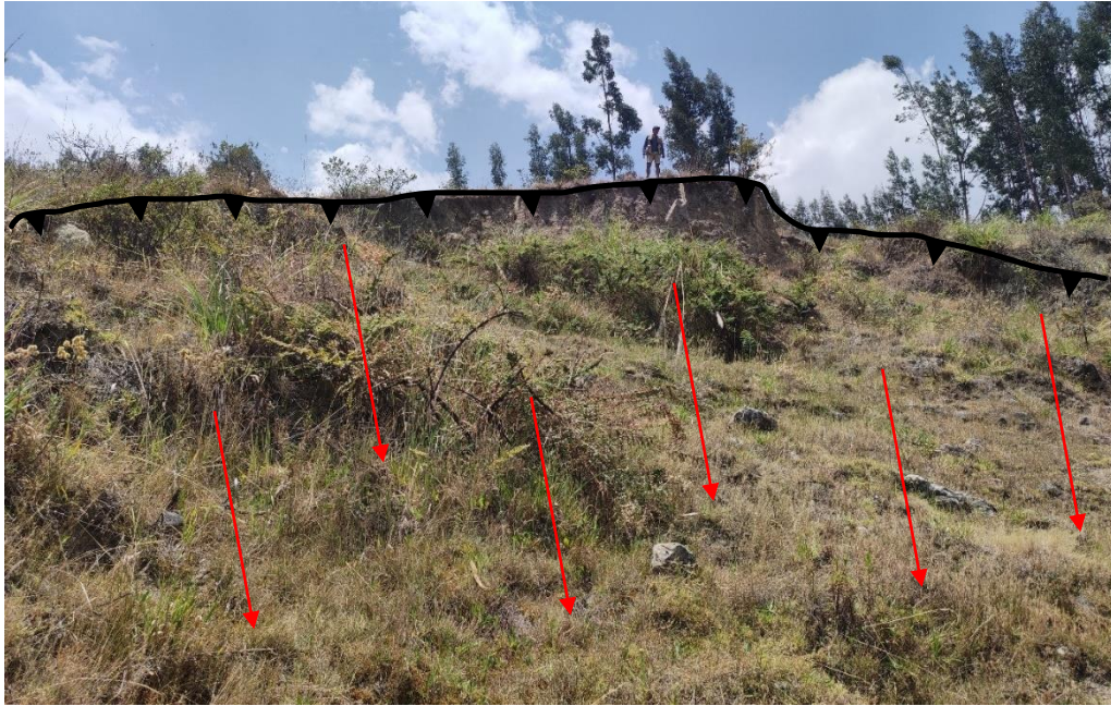
Foto 32: Deslizamiento de tipo rotacional en un pre – deslizamiento en un depósito coluvial, orientación de foto de NW – SE.
