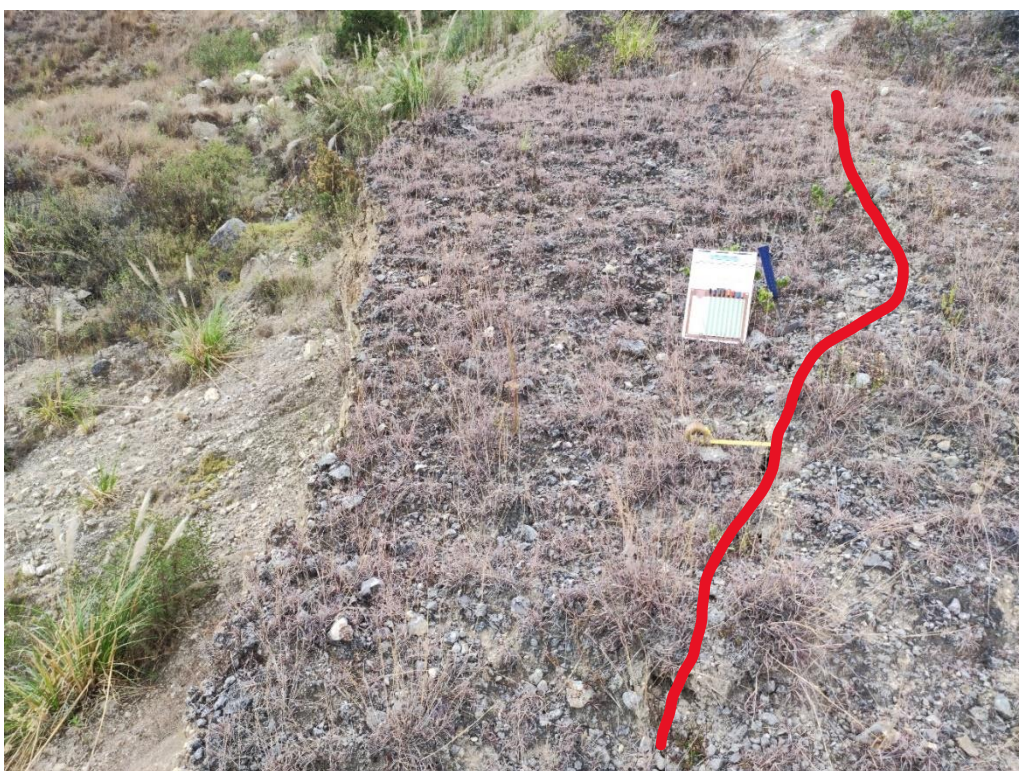
Foto 38: Grieta en el flanco derecho del deslizamiento, orientación de foto de W – E.
