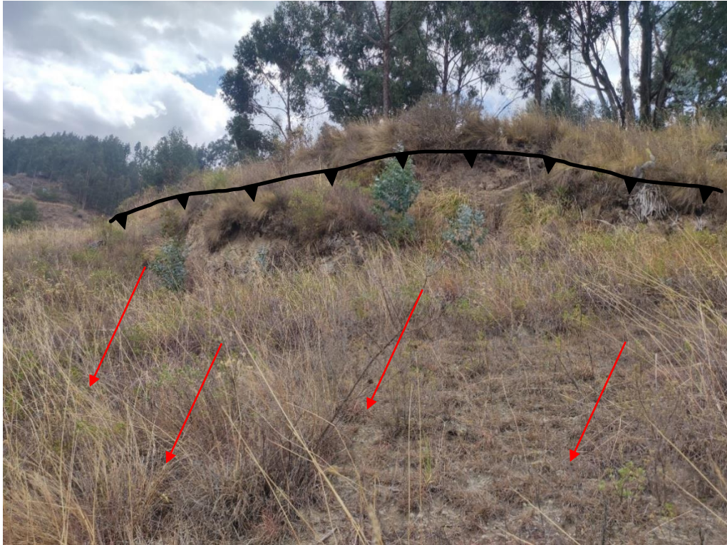
Foto 35: Deslizamiento rotacional y presencia de tobas, orientación de foto de SW – NE. Coordenadas UTM: N: 9214973 – E: 785716 – C: 2974 m.s.n.m.
