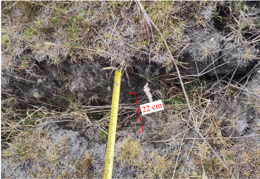
Foto 31: Agrietamiento de 22 cm. en el margen izquierdo del deslizamiento rotacional, orientación de foto de W – E.
