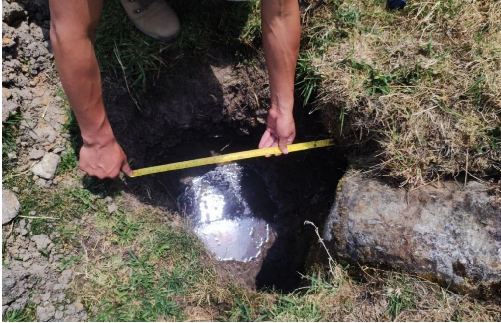
Foto 18: Evidencia del nivel freático en una calicata de 0.80 metros de profundidad y 0.50 metros de ancho, orientación de foto de W – E.
