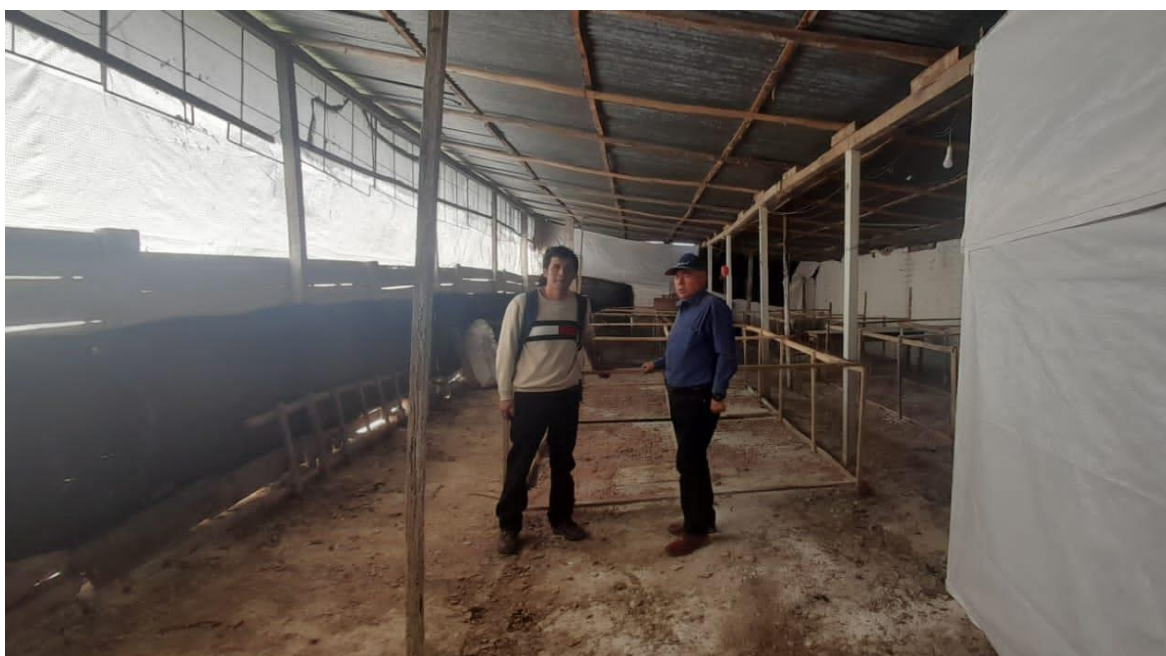
Fotografía 2. Acondicionamiento del galpón – armado de cubículos.
