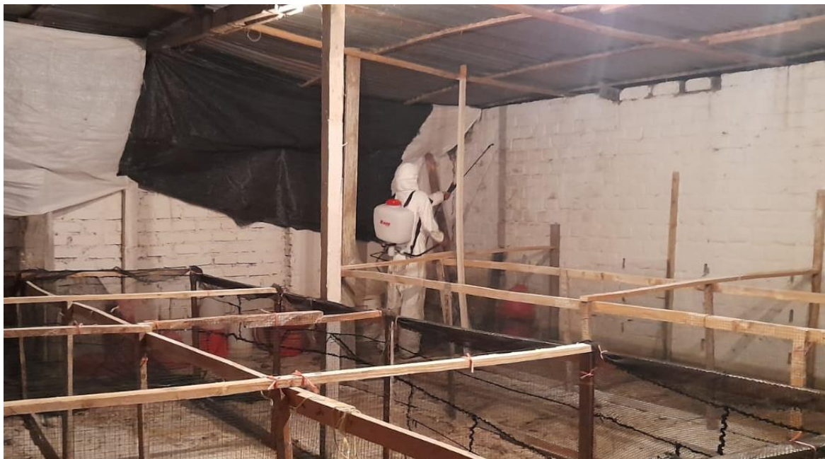
Fotografía 1. Acondicionamiento del galpón - limpieza y desinfección.
