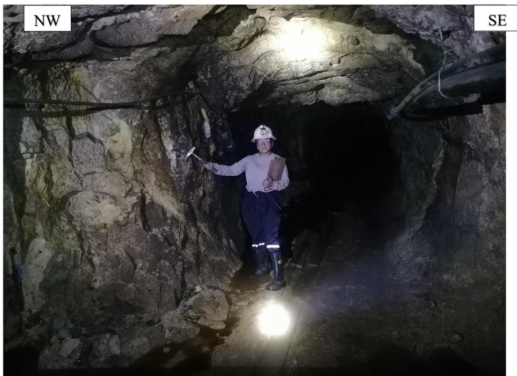
Figura 3.7. Acuífero en roca ígnea dacita generando concentraciones de agua subterránea en la solera sección subterránea.
