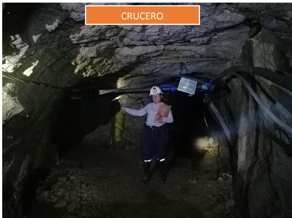
Figura 3.4. Ingreso a las Labores: Arco Iris (Derecha) y Gallito (Izquierda), conformado por arenisca de la Formación Chimú, con sección de abertura 3.50 m. y altura 2.25 m., en forma de baúl.
