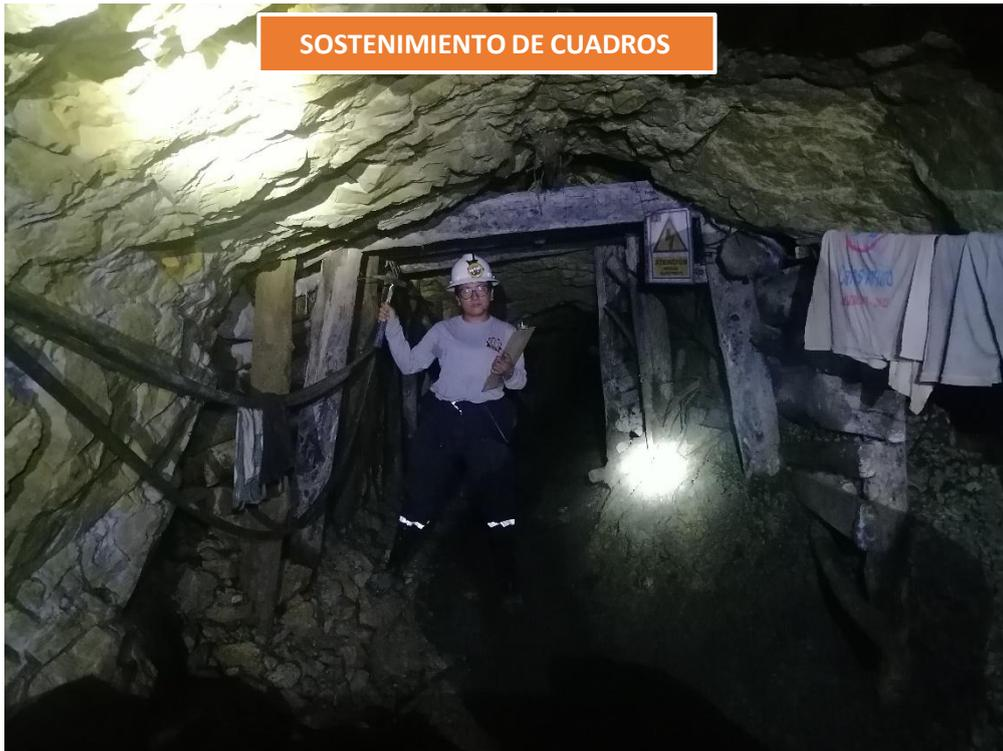
Figura 4.12. Sostenimiento por cuadros trapezoidales desde PI. + 196.20 m. a PI + 198.70 m. constituidos por maderos de eucalipto.
