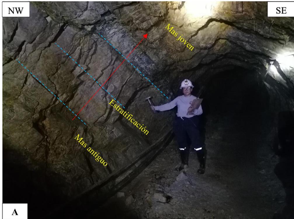
Figura 4.2. A. Las galerías: Arco Iris y Gallito, están constituidas por roca sedimentaria arenisca de orientación estratigráfica  $Az/Bz = N310^{\circ}/52^{\circ}NE$ . con grosor: 0.30 m. a 0.50 m. B. Muestra de roca arenisca de grano medio de color blanquecino, conformando la sección transversal de la excavación subterránea.
