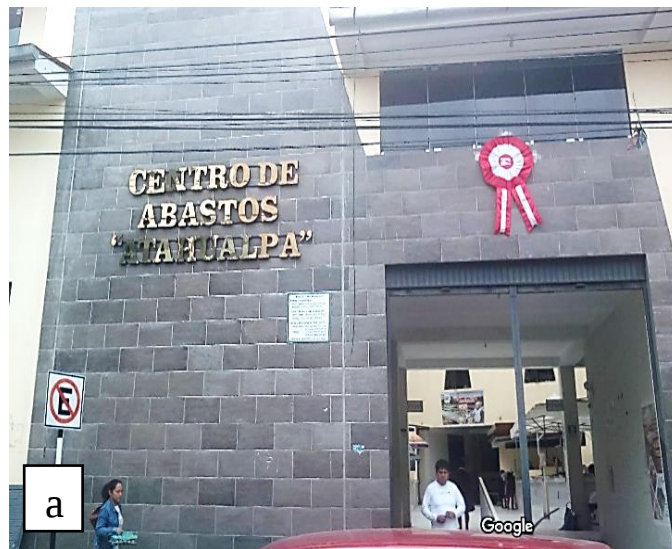
Figura a: Exteriores del Centro de Abastos "Atahualpa", donde se observa la infraestructura y el acceso principal al establecimiento.
