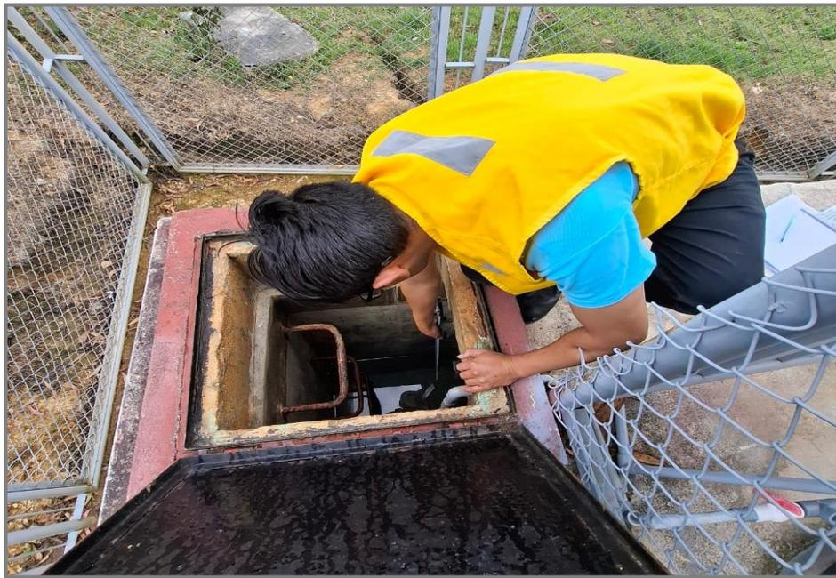
**Fotografía 8:** tubería de línea de conducción de la captación el Dungol sin enterrar
