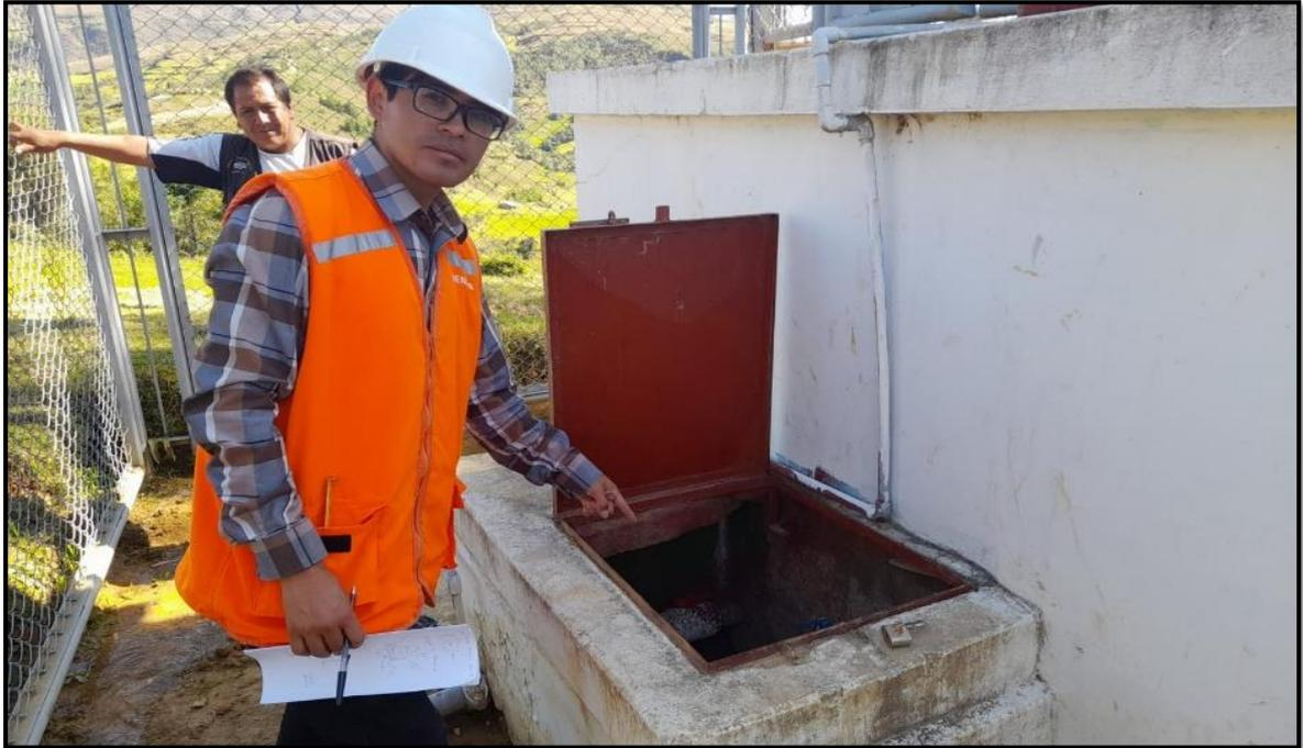
**Figura 38:** *Caja de válvulas del reservorio de la captación Dungol*
