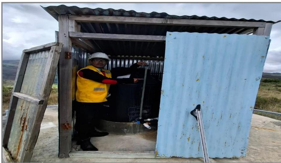
**Fotografía 6:** tubería de rebose sin dados de protección de la captación Dungol
