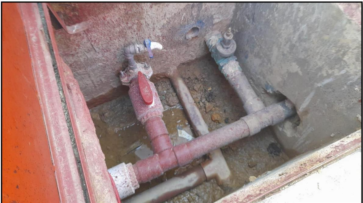
**Figura 39:** *Tubo de rebose del reservorio de la captación Dungol*
