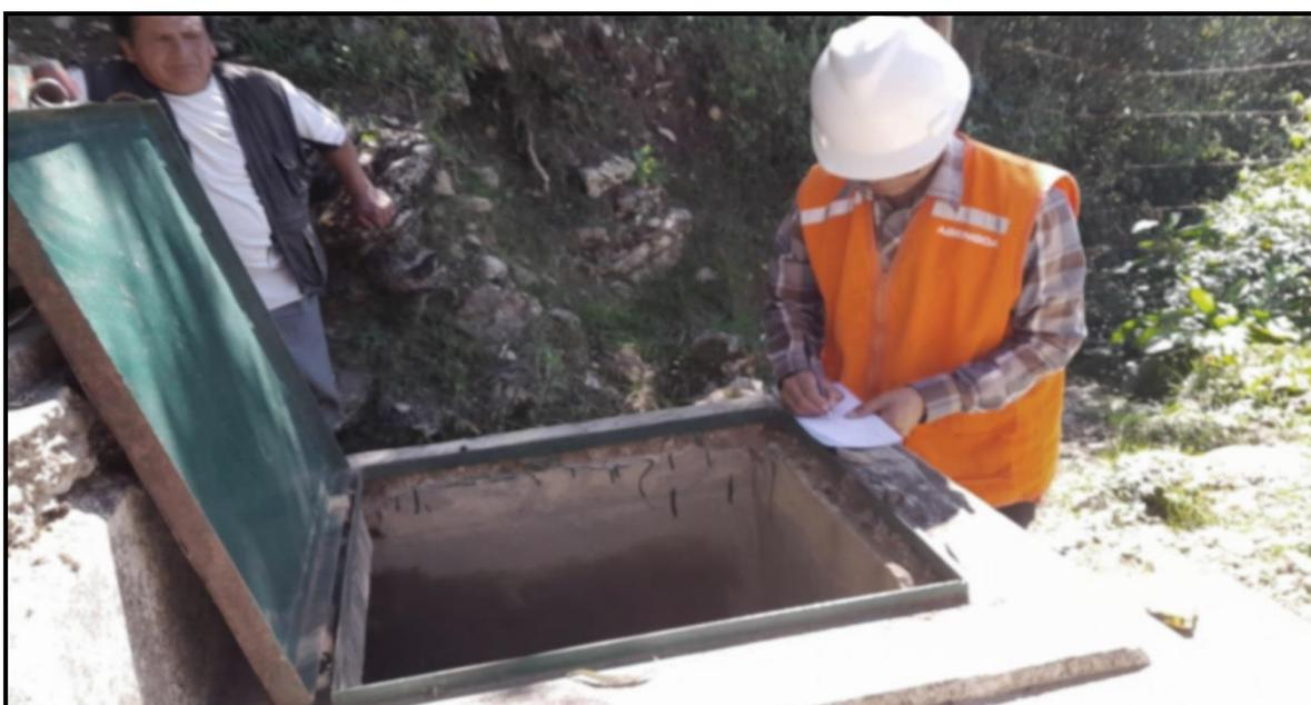
**Figura 23:** Dado de protección y tubería de rebose en mal estado
