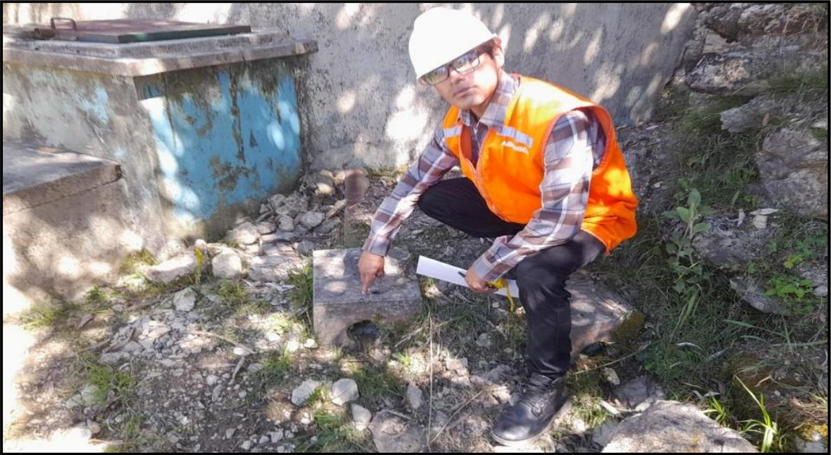
La cámara de control tiene las siguientes dimensiones 0.60m x 0.60m x 0.50m, con una tapa metálica de 0.60m y con aleros de reunión de 2.10m y 1.90m con una distancia de la cámara de control a la ladera de 2.50m.
