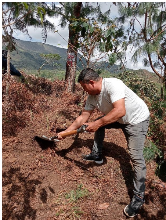
Fotos 4 y 5. Excavación de calicatas.
