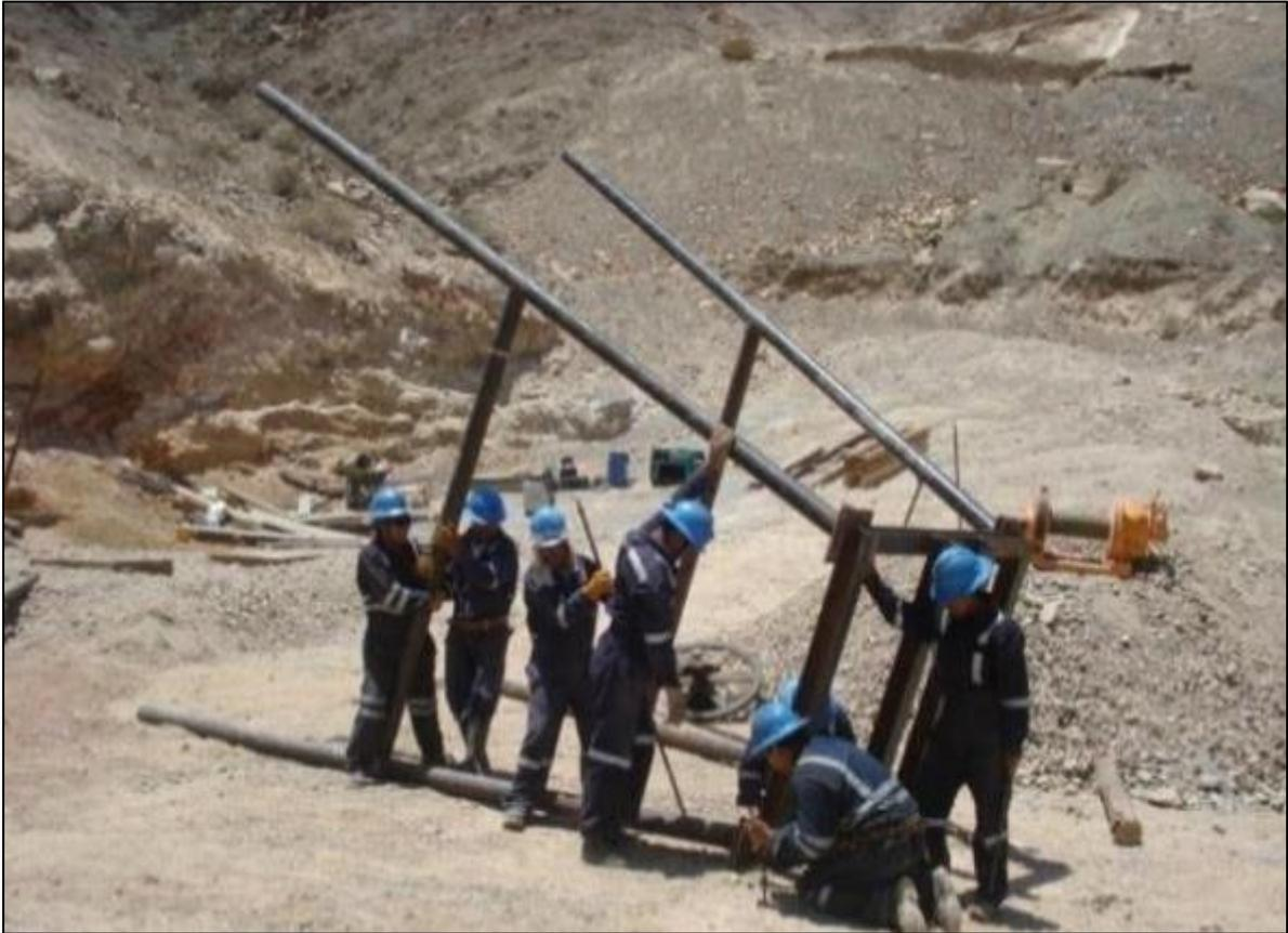
Figura 1: Instalación y acondicionamiento de castillo de izaje. (CASTILLO, 2010)
