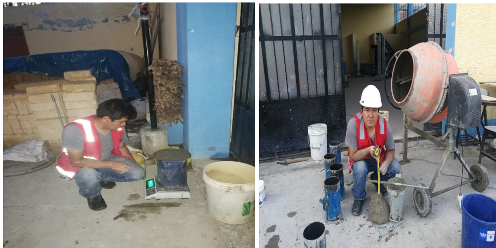
Figura 9: Medición del peso unitario y el slump (asentamiento) mediante el cono de abrams, del concreto fresco de cada tanda de mezclado.
