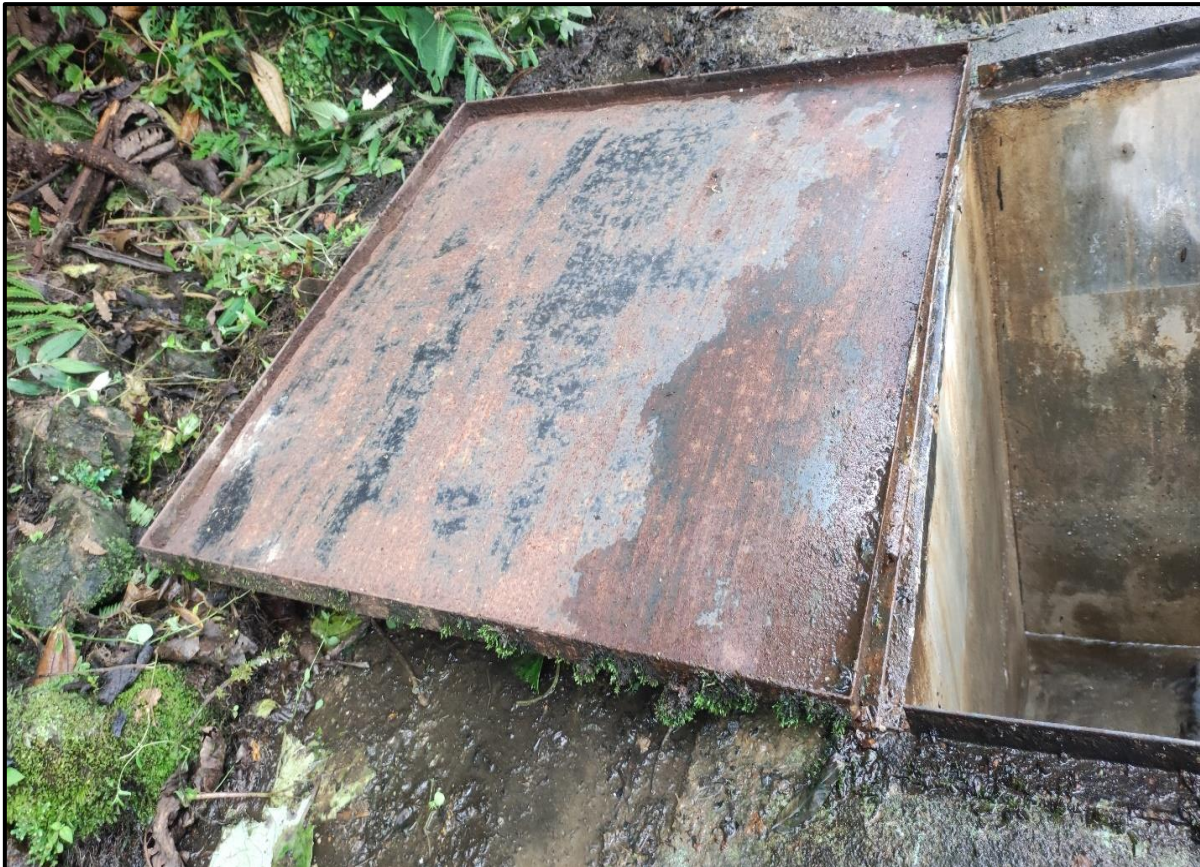
Figura 21: TAPA SANITARIA EN MAL ESTADO
