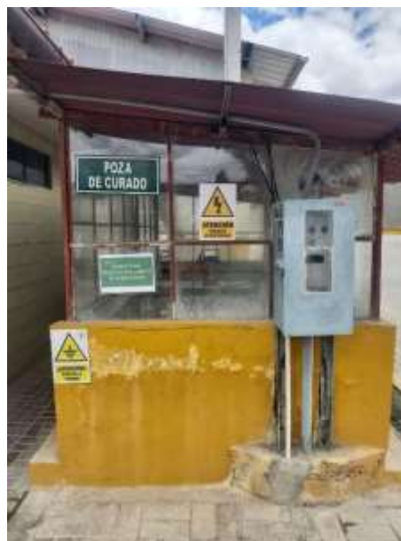
Foto N° 04: Curado de probetas de concreto en poza de curado con temperatura controlada.
