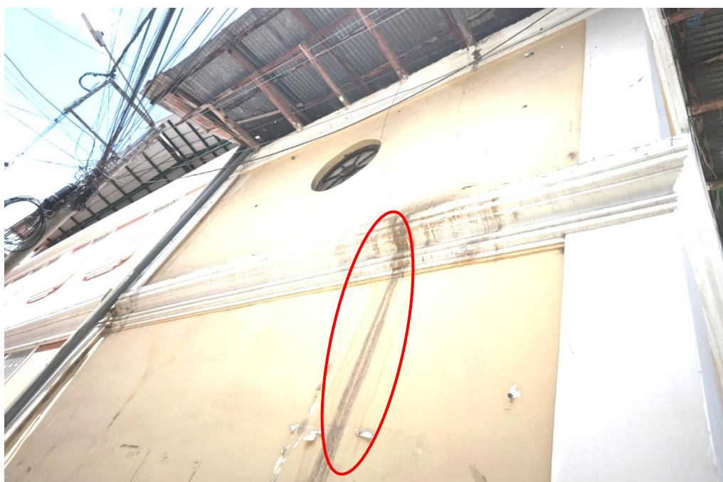
FIGURA 41. Fachada lateral de la MPSM
