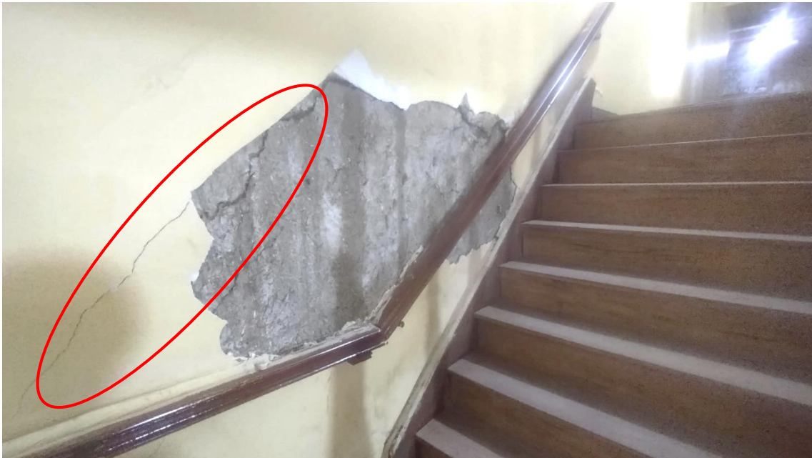
FIGURA 42. Muro adyacente a escalera en el primer piso
