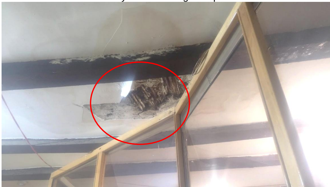
FIGURA 39. Cielo raso y techo del segundo piso
