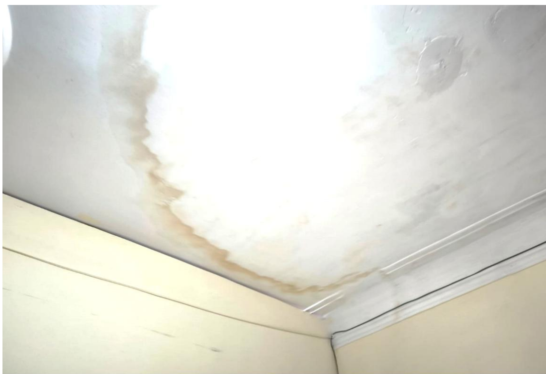
FIGURA 40. Cielo raso en el segundo piso
