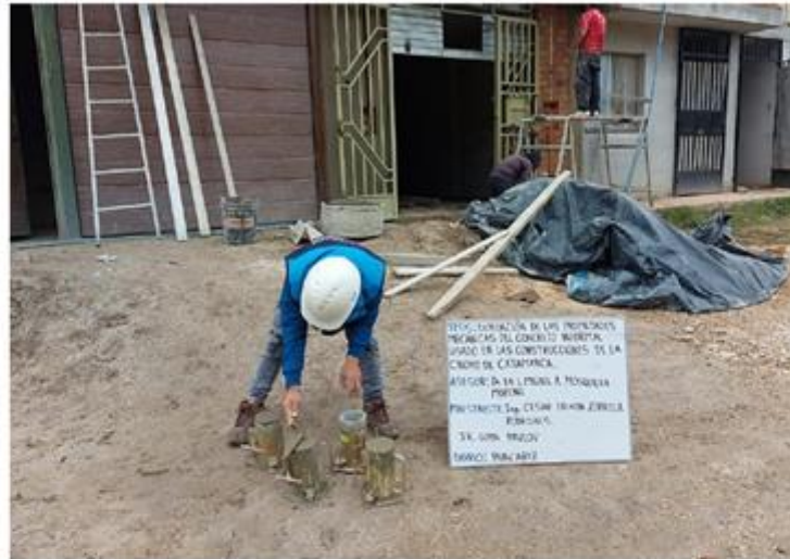
FOTOGRAFÍA N°7. Elaboración de probeta: Barrio Huacariz - Jr. Ivan Pavlov.
