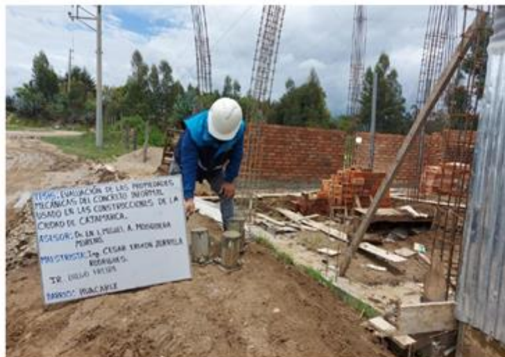
FOTOGRAFÍA N°5. Elaboración de probeta: Barrio Huacariz - Jr. Diego Freire.
