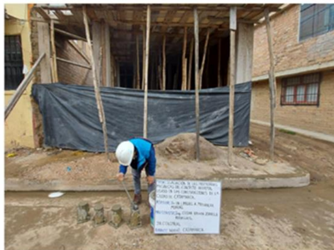
FOTOGRAFÍA N°5. Elaboración de probeta: Nuevo Cajamarca - Jr. Colonial.
