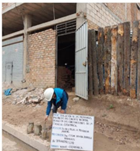
FOTOGRAFÍA N°6. Elaboración de probeta: Nuevo Cajamarca - Jr. Tahuantinsuyo.
