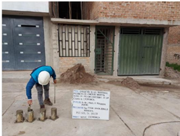
FOTOGRAFÍA N°1. Elaboración de probeta: Nuevo Cajamarca - Pje Sol De Belen.
