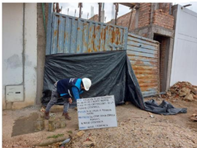
FOTOGRAFÍA N°8. Elaboración de probeta: Nuevo Cajamarca - Av. Nueva Cajamarca.
