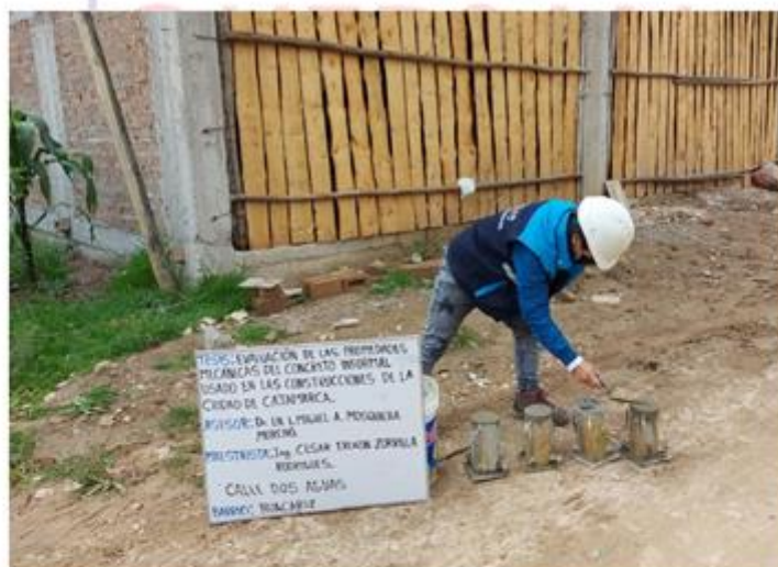
FOTOGRAFÍA N°2. Elaboración de probeta: Barrio Huacariz - Calle dos aguas.
