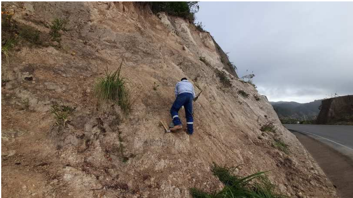
Figura 22 Calicata y recolección de muestra en el km 84+010.
