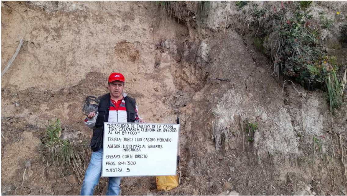
Figura 23 Tesista en el talud km 84+300.
