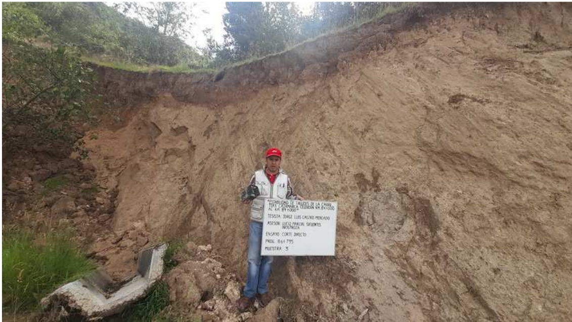
Figura 27 Tesista en el talud km 86+735.
