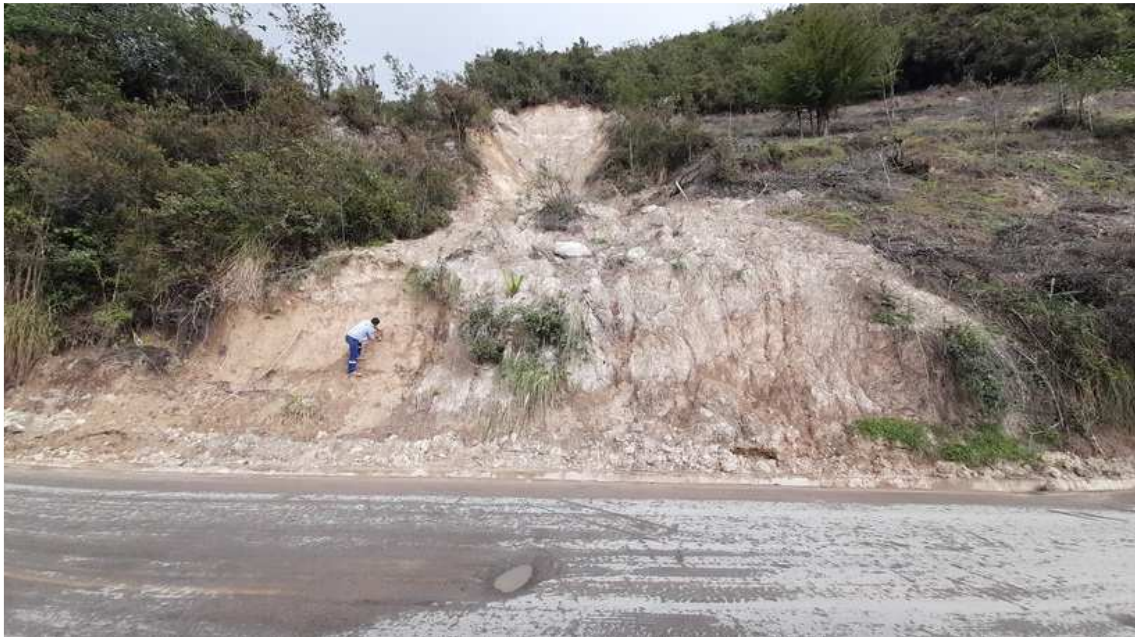
Figura 24 Calicata y recolección de muestra en el km 84+300.
