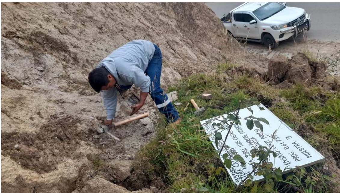
Figura 28 Calicata y recolección de muestra en el km 86+735.
