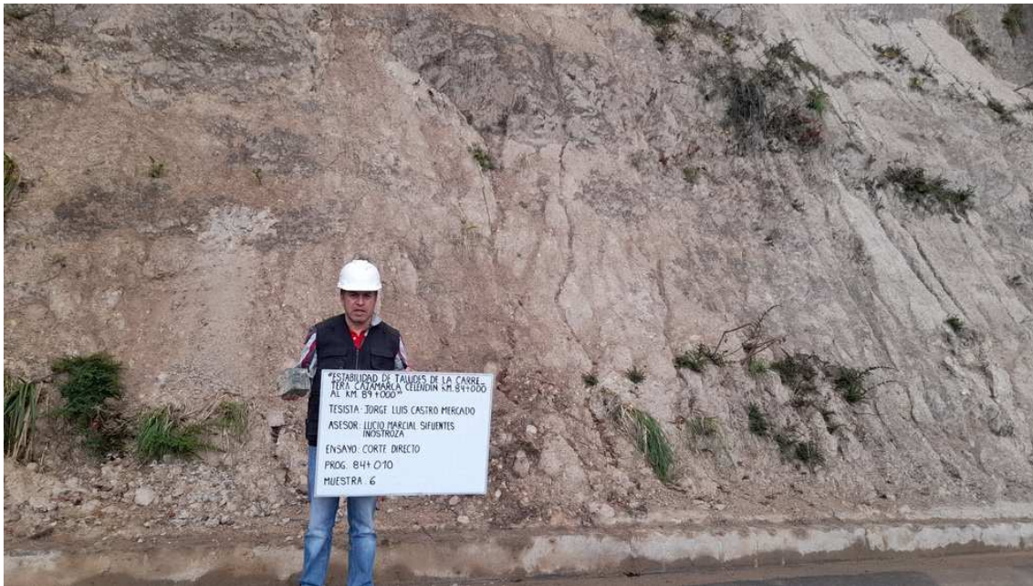
Figura 21 Tesista en el talud km 84+010.
