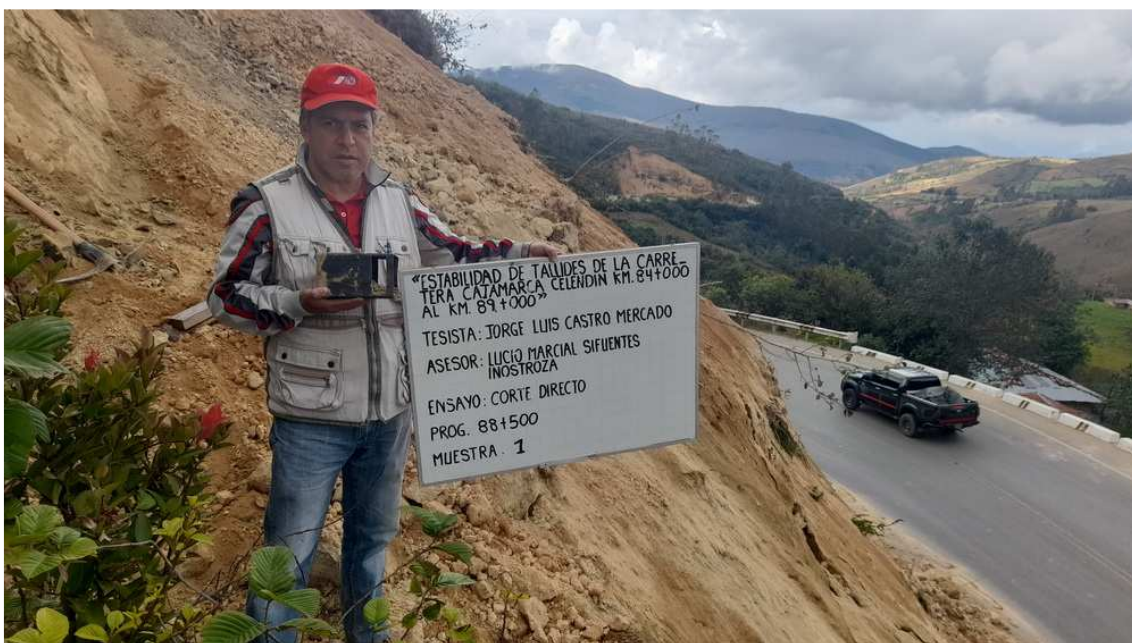
Figura 32 Calicata y recolección de muestra en el km 88+500.
