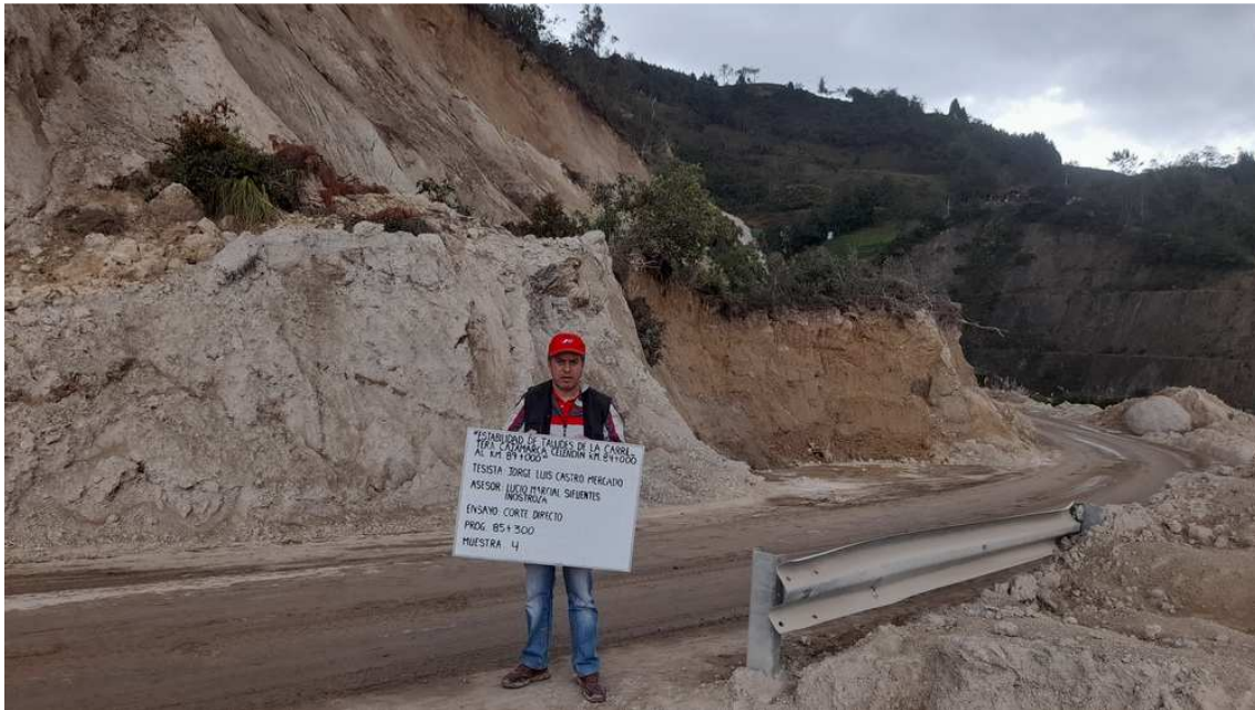
Figura 25 Tesista en el talud km 85+300.
