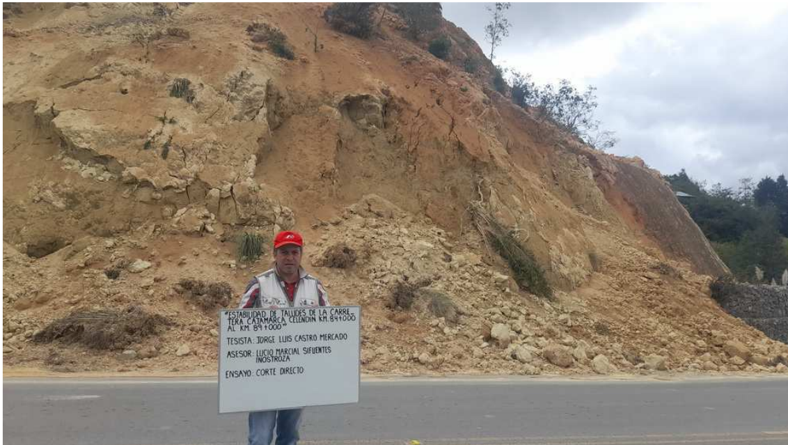
Figura 31 Tesista en el talud km 88+500.
