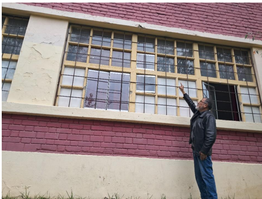
Figura 18. Inspección de patologías presentes a cargo del Ing. Marcos Mendoza L.
