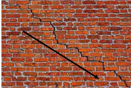
Figura 1. Fisuras diagonales
