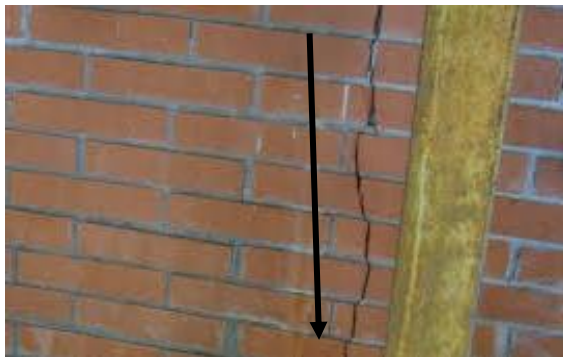
Figura 2. Fisuras verticales
