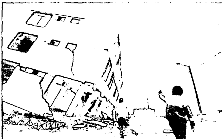
Fig. 3. Daños en colegio por las altas vibraciones generadas durante un evento sísmico. (Pisco 2007)
