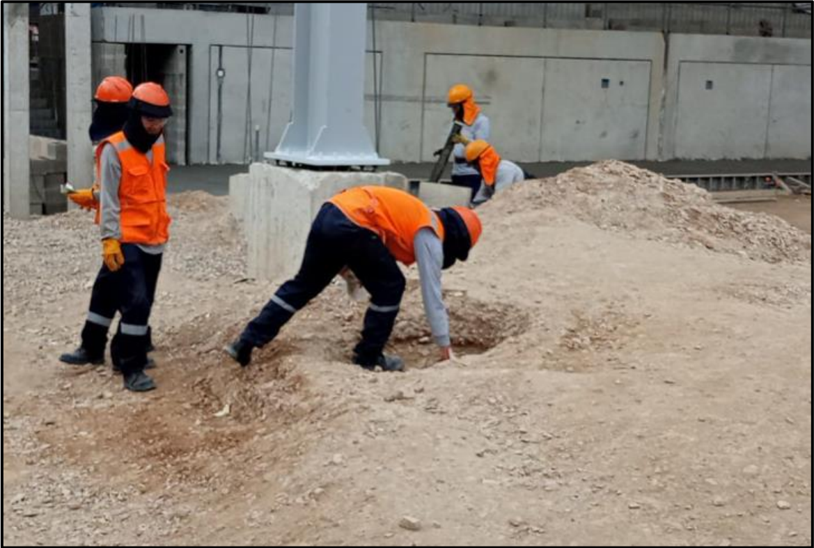
Fotografía 8: Implementación de Equipo de protección al personal.
