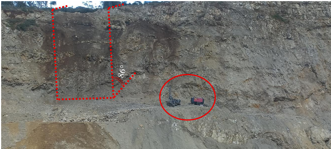
Figura 35. Equipos de Perforación en Talud
