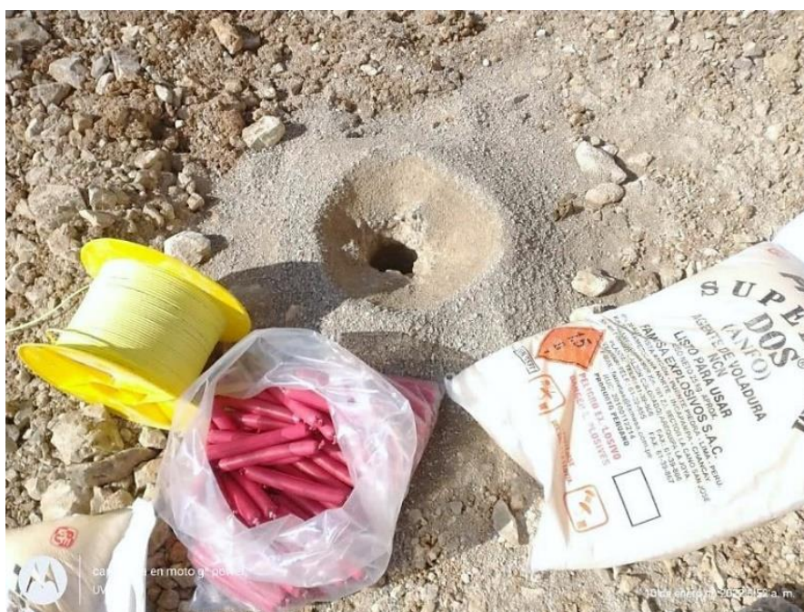
Figura 19. Cargado de Taladros
