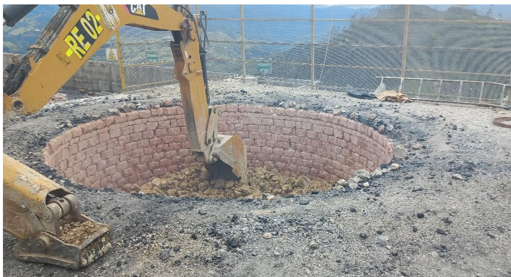
Figura 40. Llenado del Horno con Maquinaria
