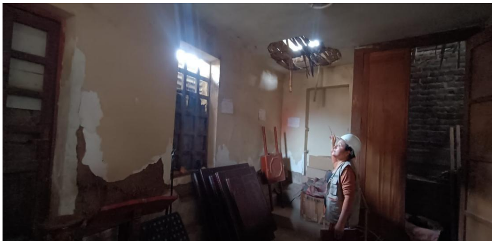
Foto 7. Observando desprendimiento parcial del techo en almacén.
