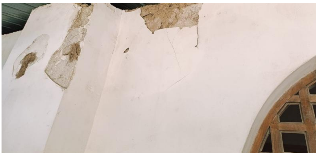
Foto 9. Desprendimiento de revestimiento.
