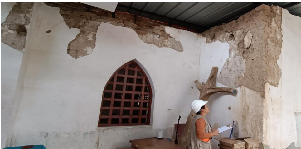
Foto 6. Verificando desprendimiento del revestimiento.
