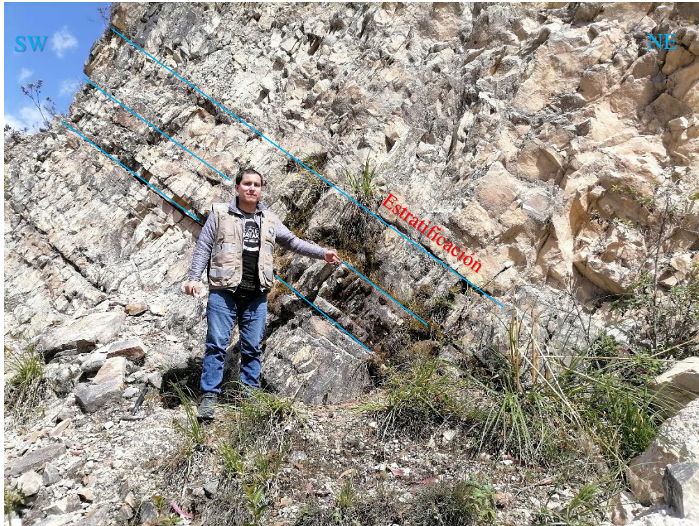
Figura 14. Progresiva Km. 11+500 – el talud de corte está conformado por rocas de la Formación Carhuaz, compuesta por estratos de areniscas cuarzosas de espesor: 0.20 m. a 0.30 m. de calidad media.
