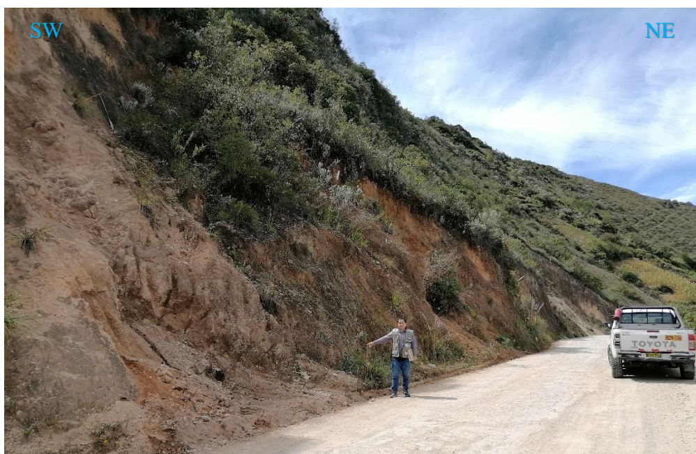
Figura 17. Ubicado en la progresiva Km. 13+440, en el lado izquierdo de la carretera, constituido por materiales deleznales de coloraciones anaranjadas.
