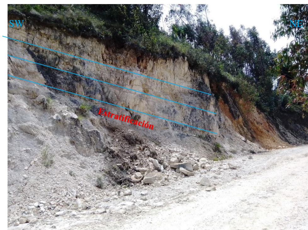
Figura 12. Progresiva Km. 11+100 – Formación Chimú, ubicada en el flanco izquierdo de la carretera compuesta por estratos de areniscas de grano grueso a fino estratos: 0.15 m a 0.35 m., con orientación: Az = N300^\circ y Bz = 60^\circ NE .
