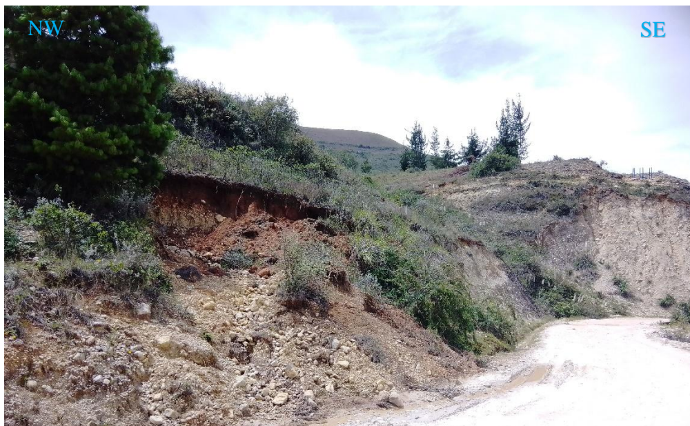
Figura 18. Ubicada en la progresiva Km. 11+600, del lado izquierdo evidenciándose por la saturación de los niveles freáticos en las partes altas de los taludes.
