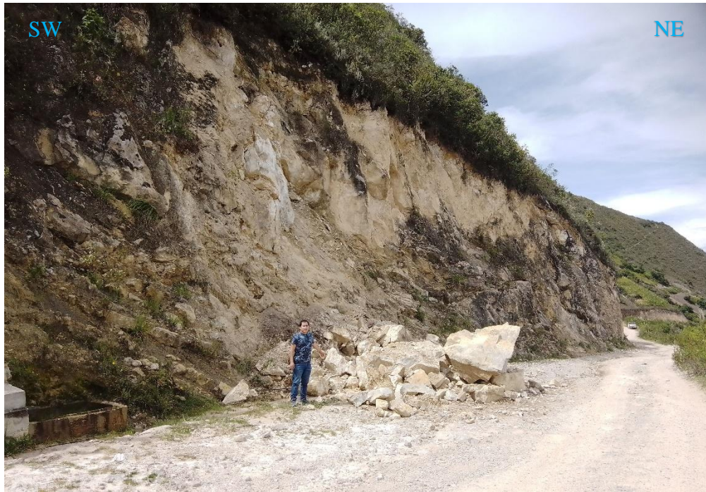
Figura 29: Caída de rocas en la Formación Chúlec, ubicado en la progresiva: Km. 13+300 a Km. 13+390.
