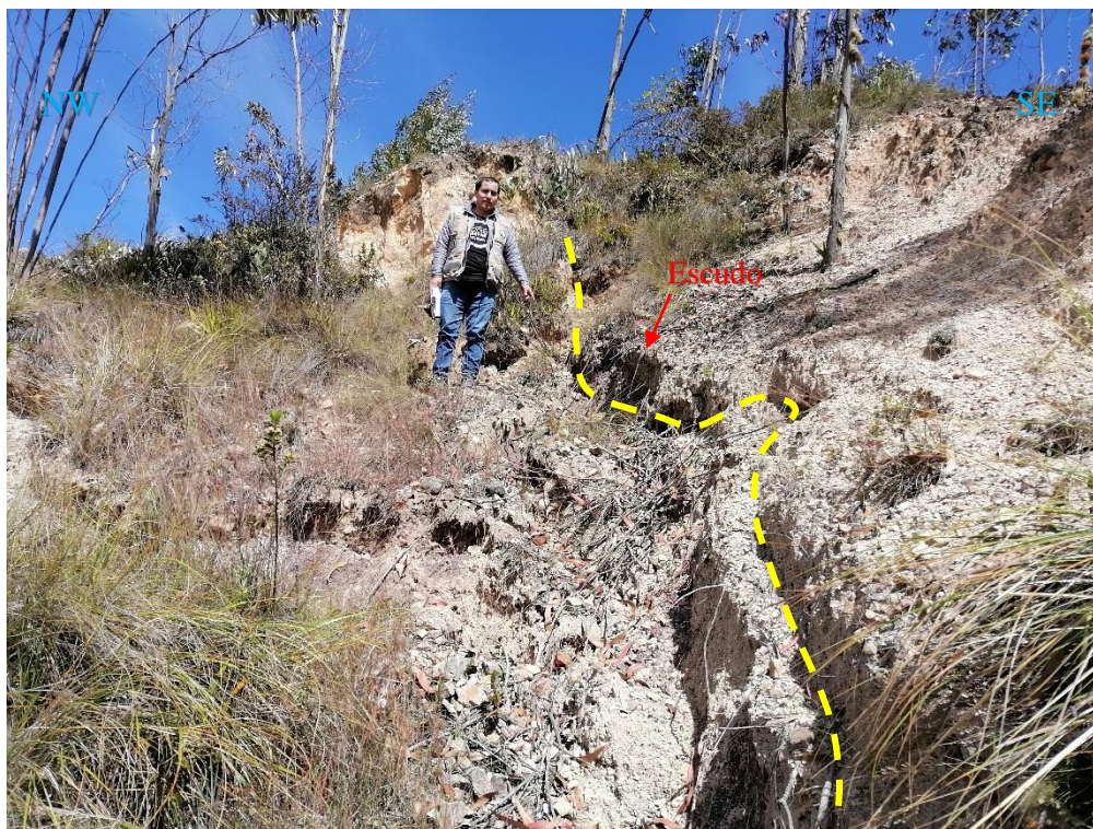
Figura 28: Delimitación del deslizamiento circular de pie, ubicado en el lado izquierdo con desplazamiento de 0.50 m. a 0.60 m. Afectado progresivamente la parte superior de la ladera por el agrietamiento en el terreno. Ubicada desde la progresiva: Km. 11+385 a Km. 11+820.
