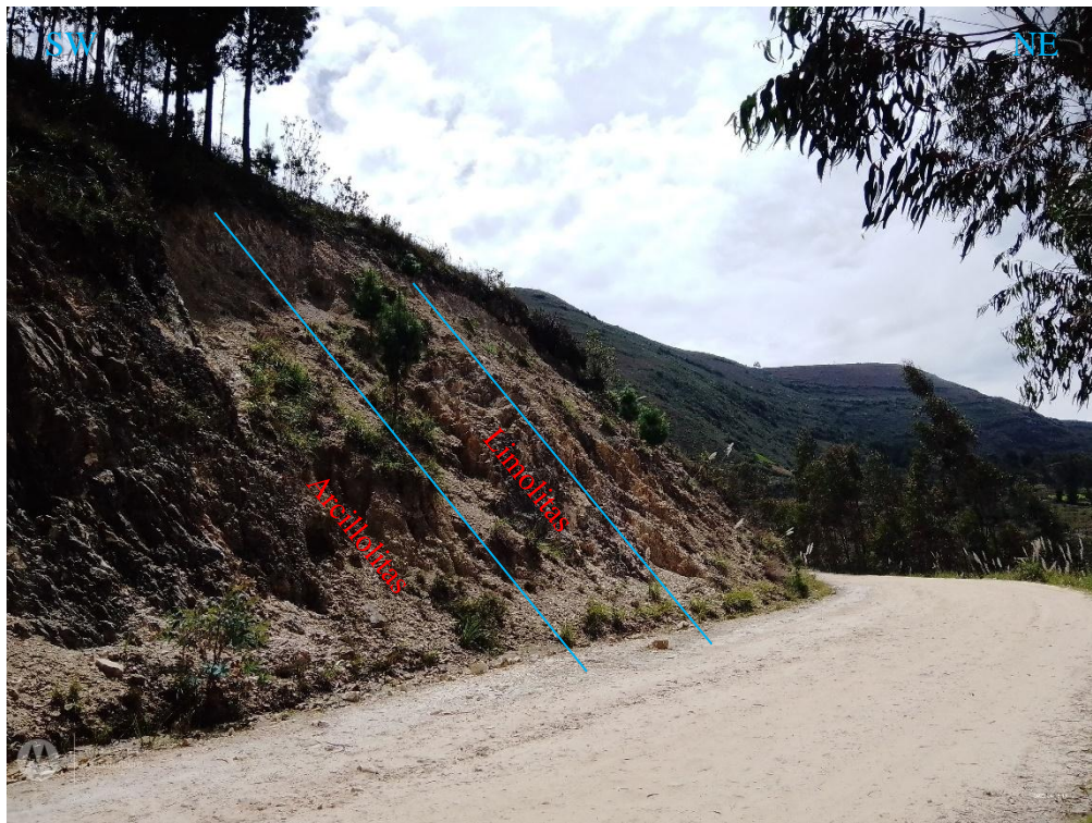
Figura 13. Progresiva Km. 11+250 – Formación Santa, ubicado en la margen izquierda de la carretera presenta secuencias: Lutáceas y limolíticas de textura frágil a muy frágil, siendo muy susceptible a la meteorización y erosión, de la superficie de roca.
