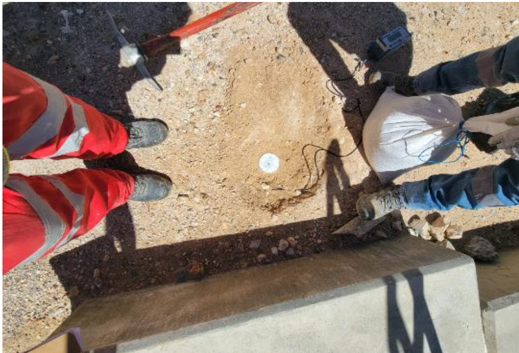
Figura 37 Instalación del geófono según el estándar establecido.
