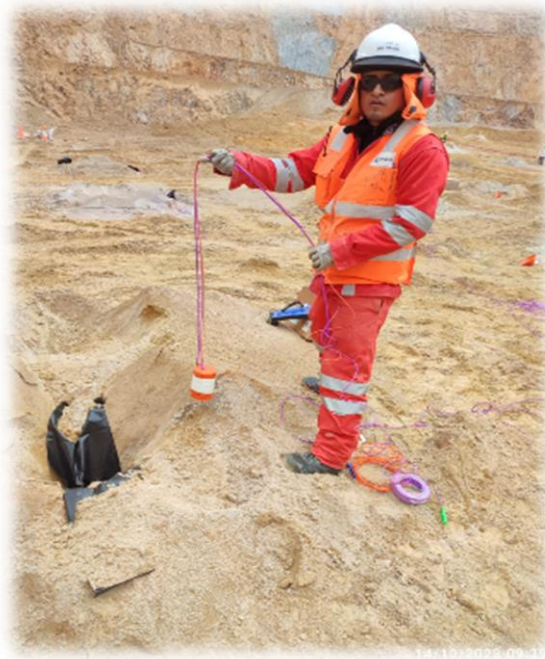
Foto 1 Colocación del Booster
