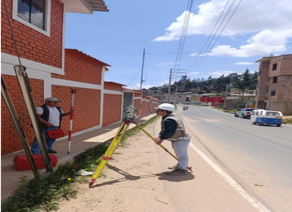
Fotografía N° 16: Levantamiento topográfico al inicio, C.P. Huambocancha Alta
