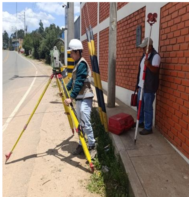
Fotografía N° 3: Trípode usado durante el levantamiento topográfico
