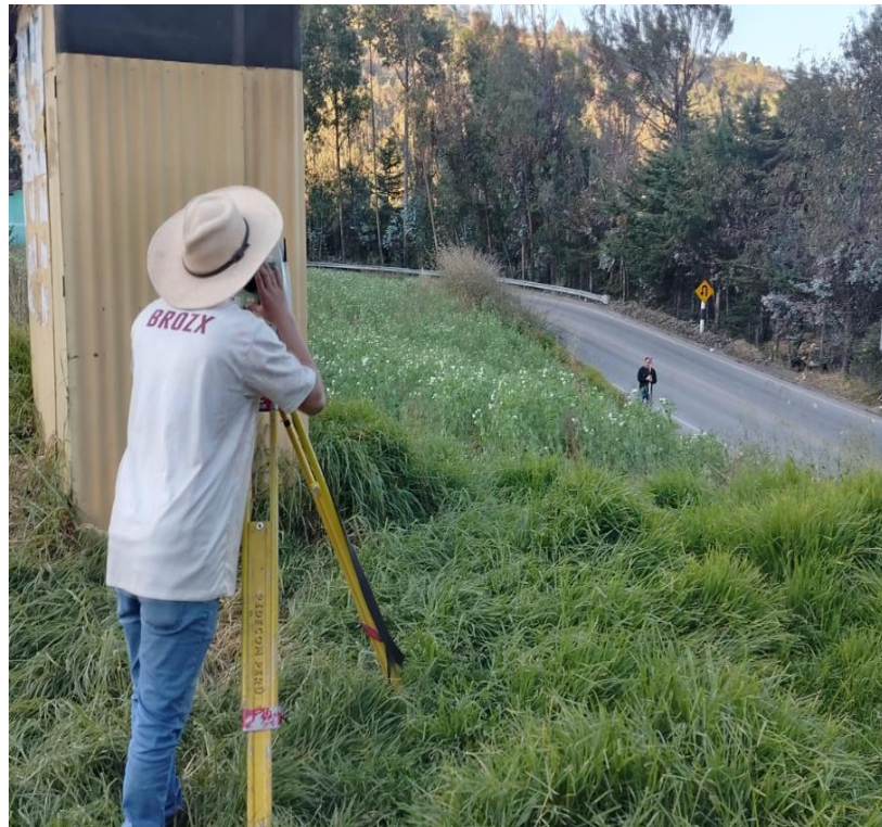
Fotografía N° 14: Cuarto día de levantamiento topográfico curva de vuelta
