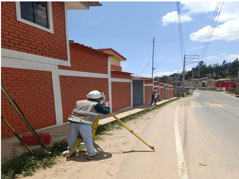
Fotografía N° 17: Levantamiento topográfico al inicio, C.P. Huambocancha Alta
