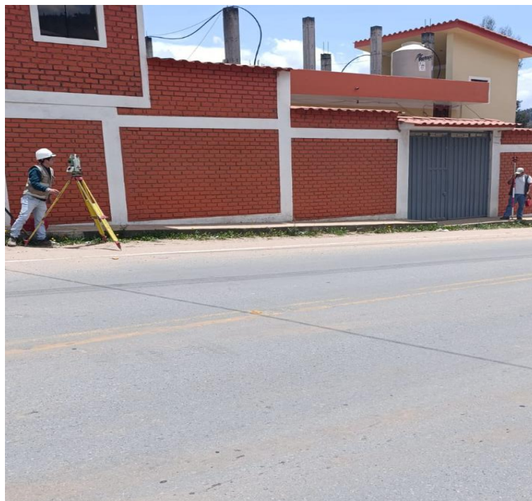
Fotografía N° 9: Levantamiento topográfico de borde de berma
