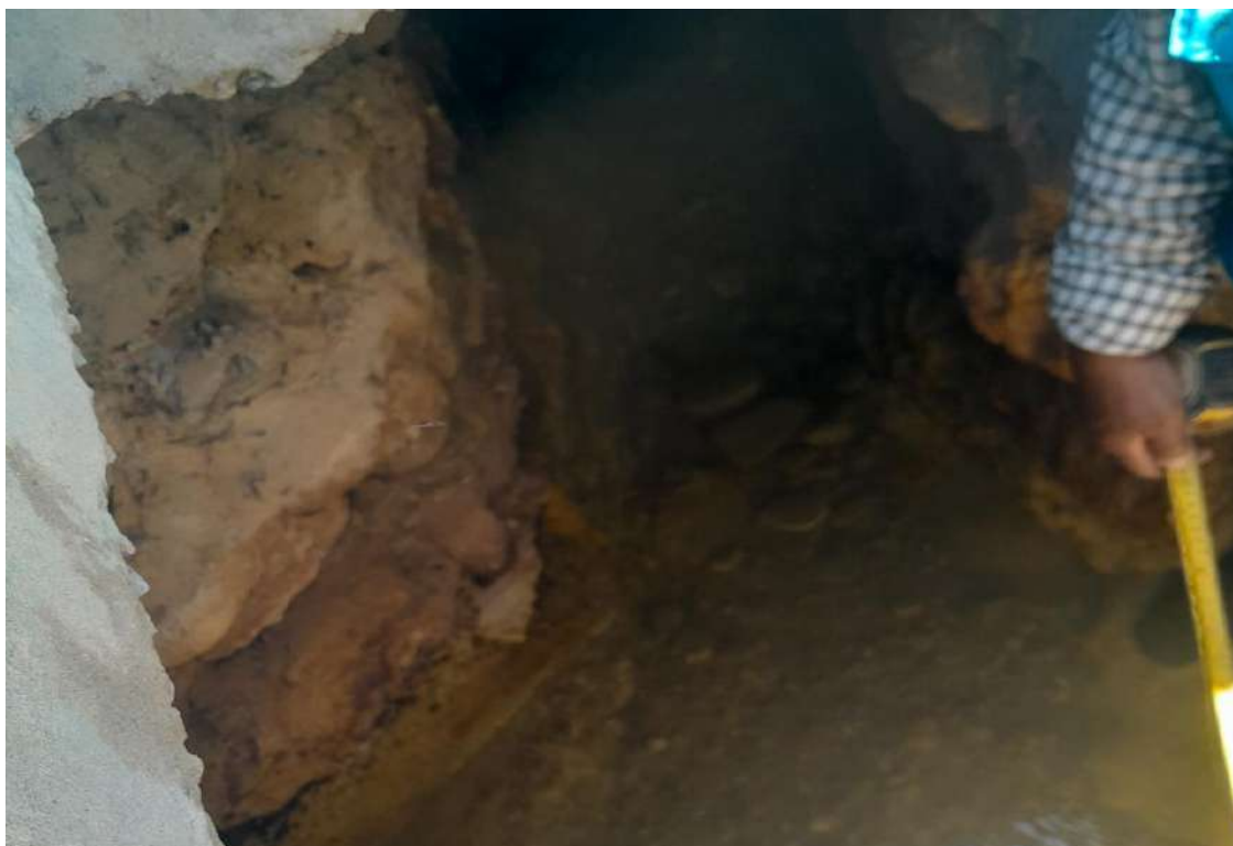
Figura 25: Detalles de manantial de fondo en captación N.º 1
