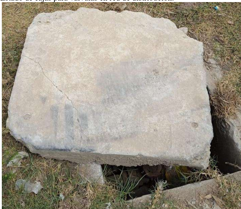
Figura 46: Estado de cajas para válvulas en red de distribución.
