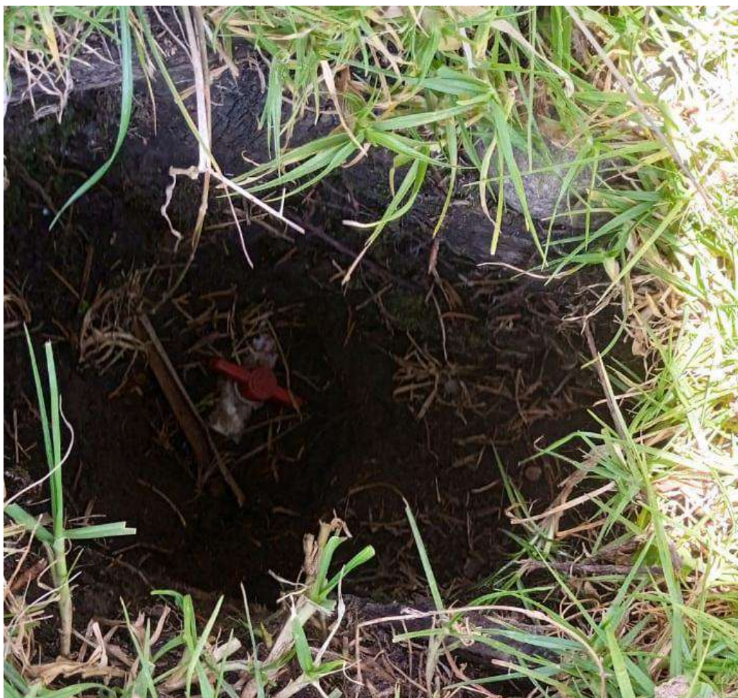
Figura 47: estado de llaves de control en red de distribución
