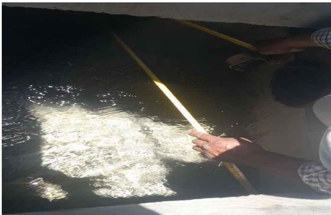
Figura 36: Detalle del interior de la cámara de reunión N°1
