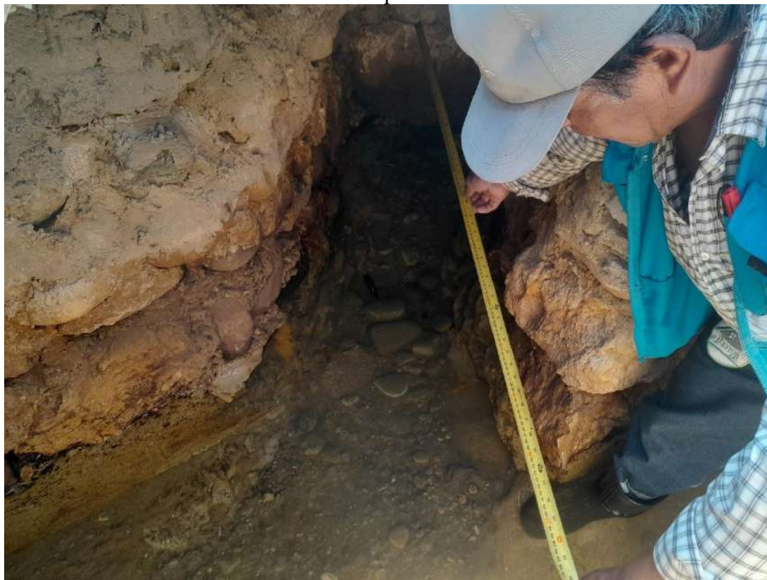
Figura 29: detalles de manantial de fondo en captación N.º 2
