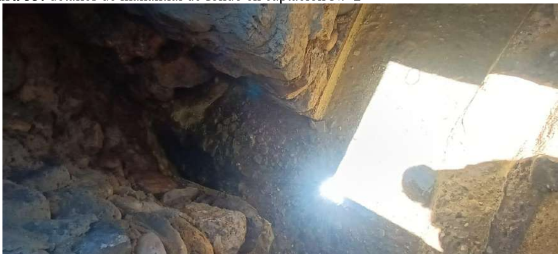
Figura 33: detalles de manantial de fondo en captación N.º 2
