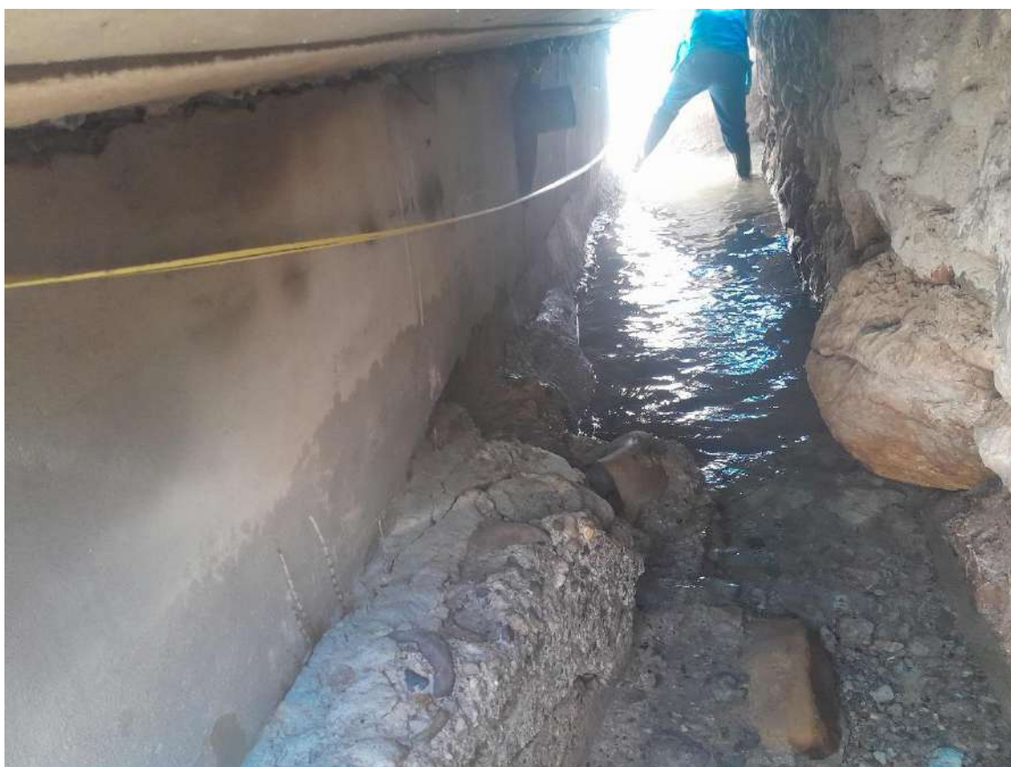
Figura 28: Medición de dimensiones en el interior de la captación N.º 2
