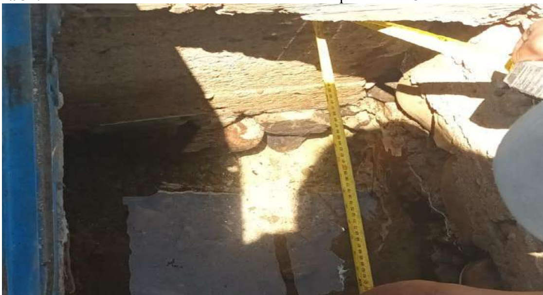
Figura 32: Medición de dimensiones en el interior de la captación N.º 3
