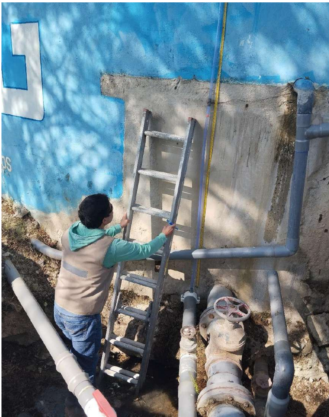
Fotografía 7 toma de niveles piezométricos en reservorio.
