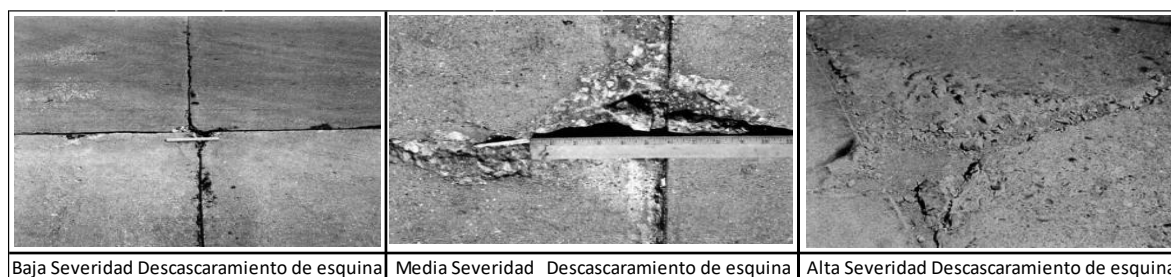
Figura 21. Nivel de Severidad del Descascaramiento de Junta
