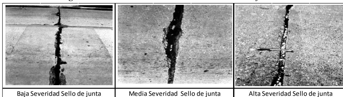
Figura 9. Nivel de Severidad en los daños del sello de junta
