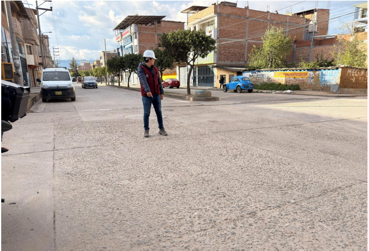
Figura 173. Falla (32) – Popouts tomada en campo
