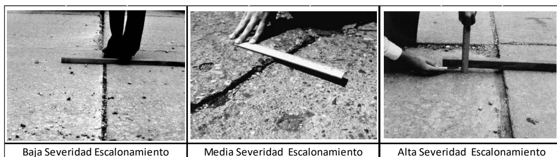
Figura 8. Nivel de Severidad para la escala
