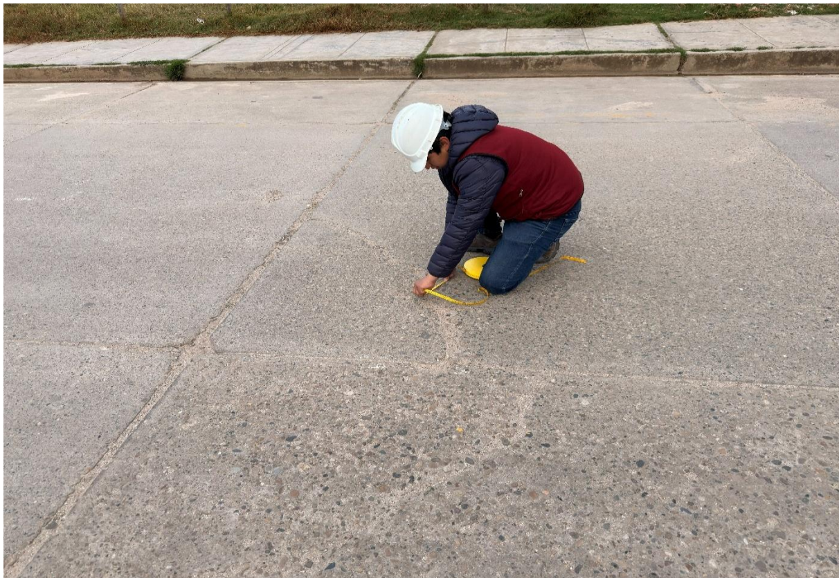
Figura 165. Falla (22) - Grieta de Esquina tomada en campo
