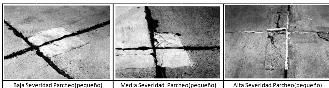
Figura 13. Nivel de Severidad del parcheo pequeño
