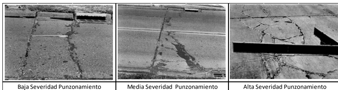
Figura 17. Nivel de Severidad del punzonamiento
