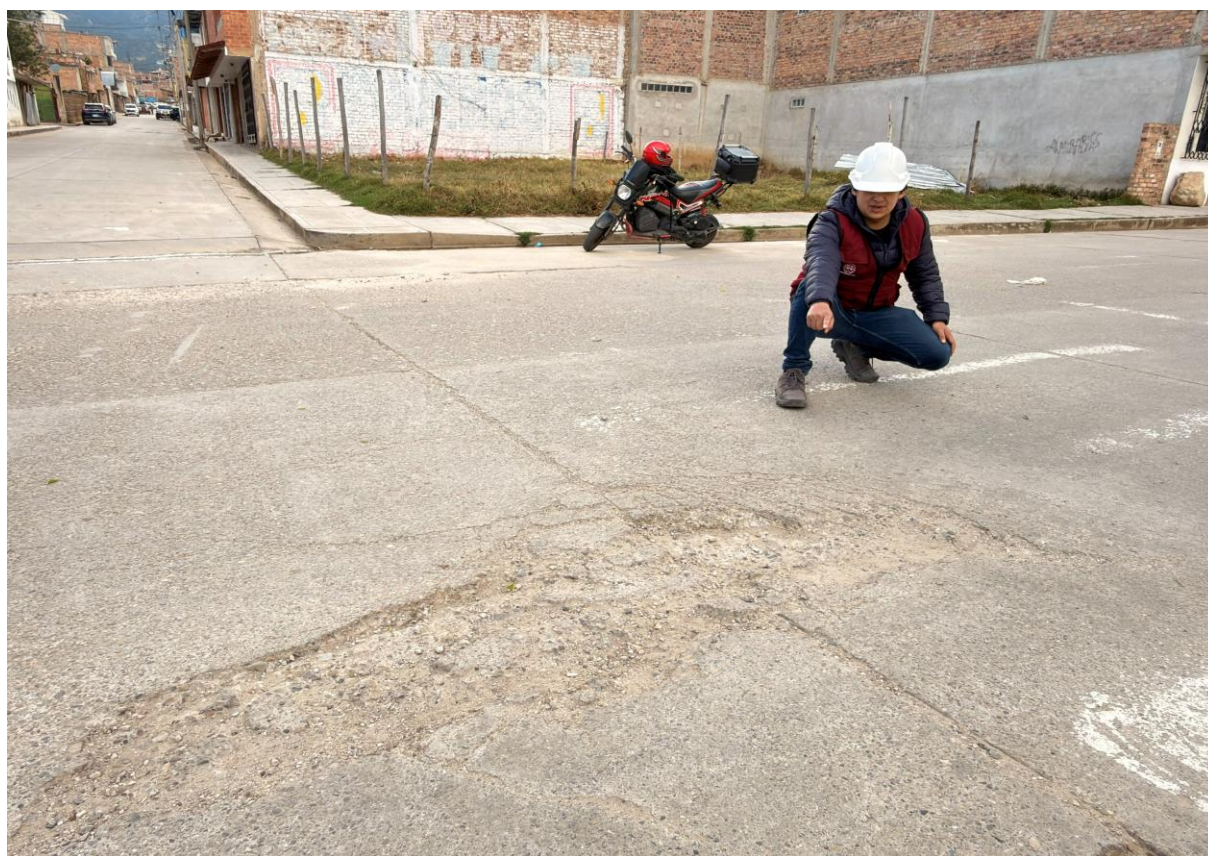
Figura 167. Falla (24) – Grieta de Durabilidad D tomada en campo
