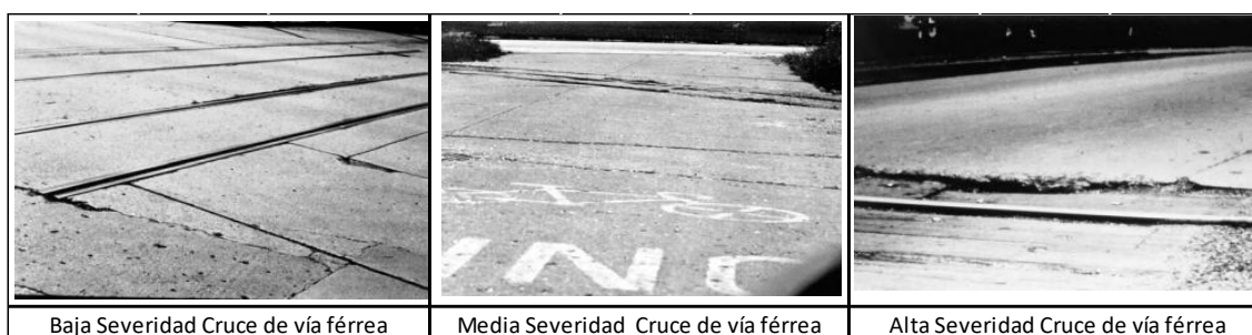
Figura 18. Nivel de Severidad del Cruce de vía Férrea
