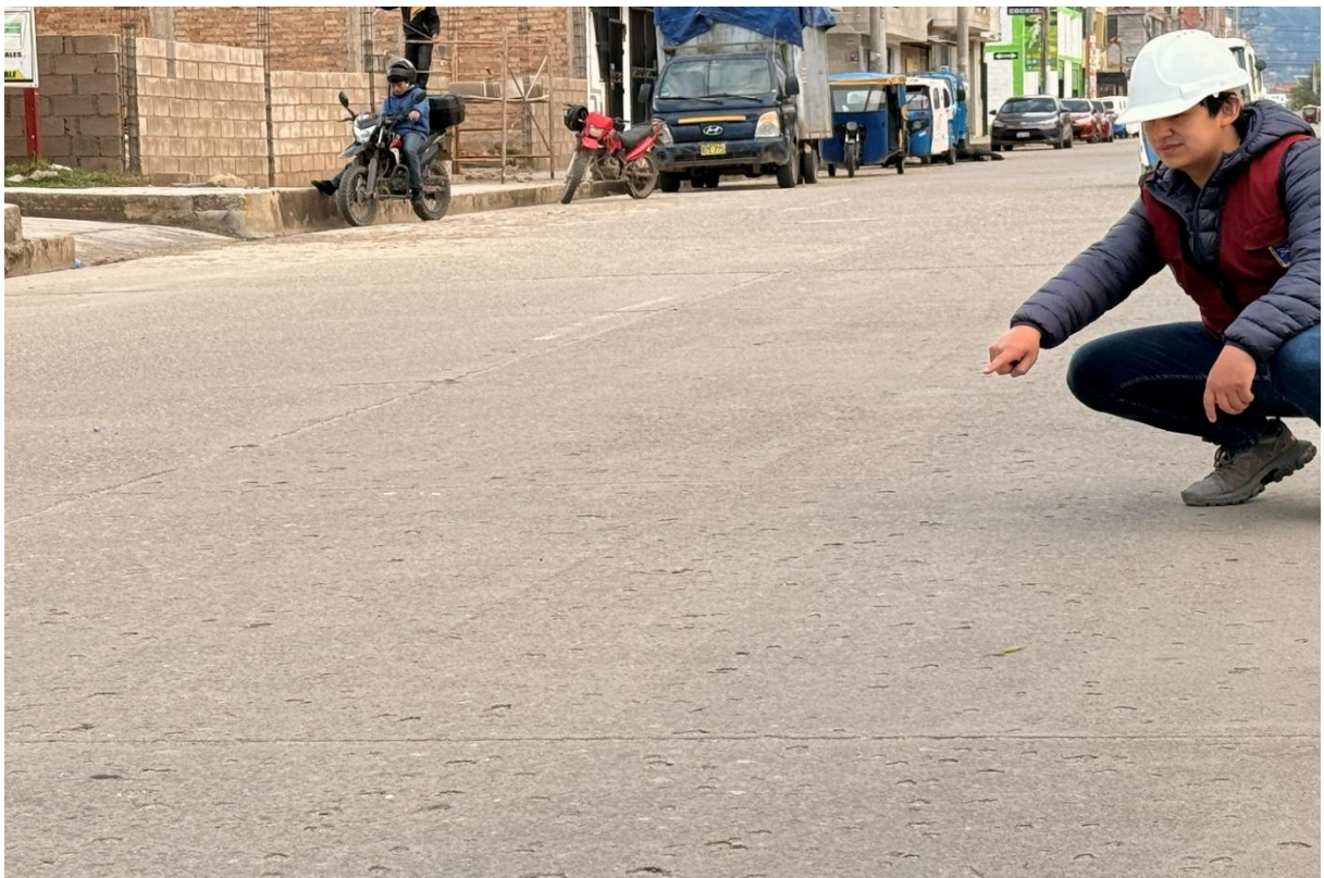
Figura 173. Falla (32) – Popouts tomada en campo
