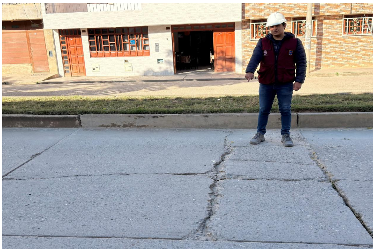
Figura 167. Falla (24) – Grieta de Durabilidad D tomada en campo
