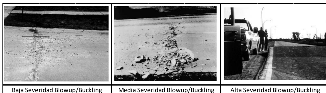
Figura 4. Nivel de Severidad del Blowup/Buckling
