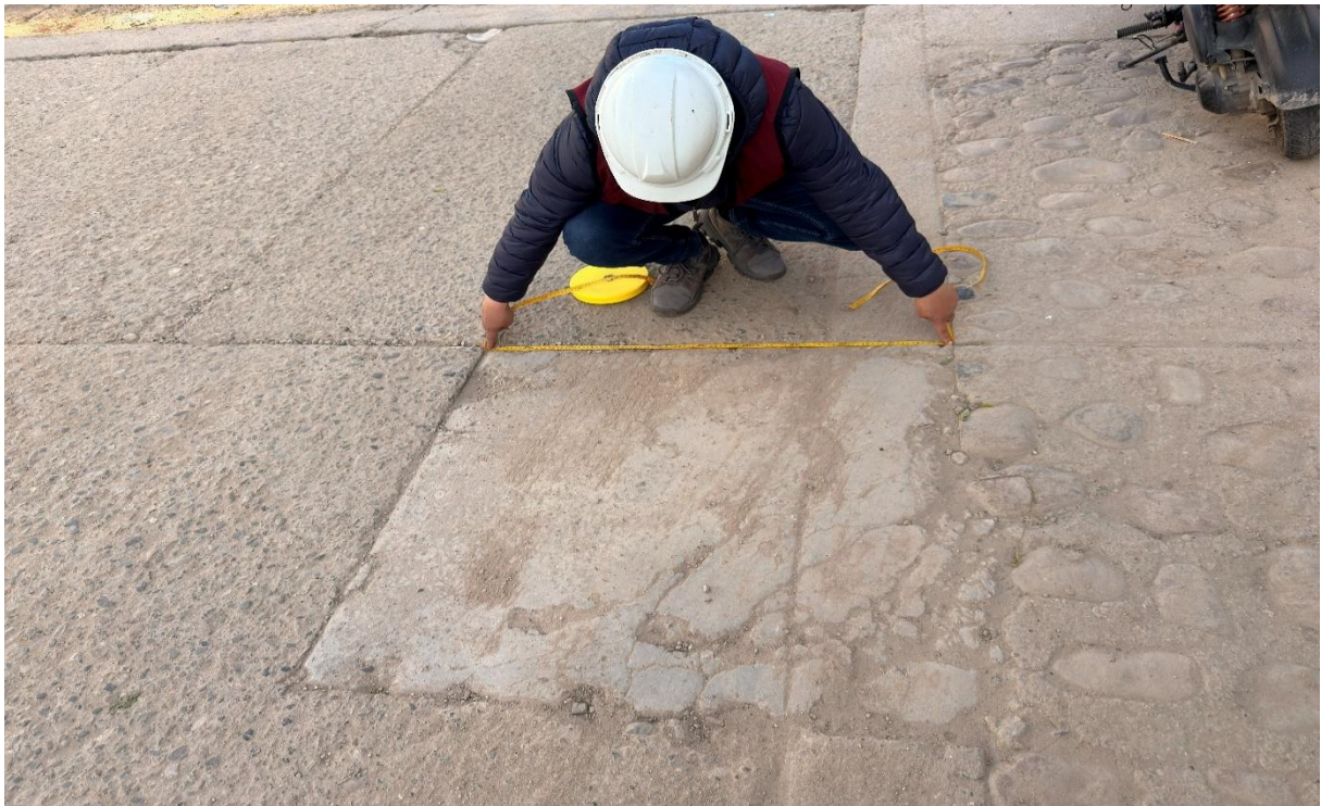
Figura 171. Falla (30) – Parcheo Pequeño tomada en campo
