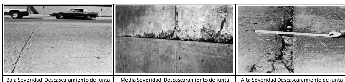
Figura 22. Nivel de Severidad del Descascaramiento de Junta
