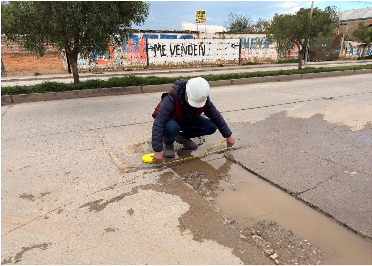
Figura 170. Falla (29) – Parcheo grande tomada en campo
