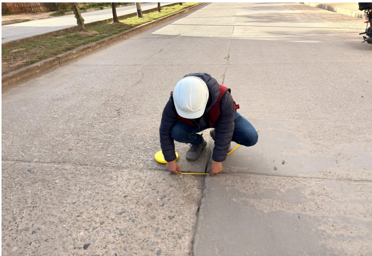
Figura 177. Falla (39) – Descascaramiento de junta tomada en campo
