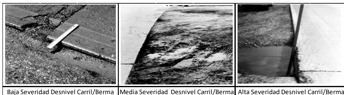
Figura 10. Nivel de Severidad desnivel carril/berma
