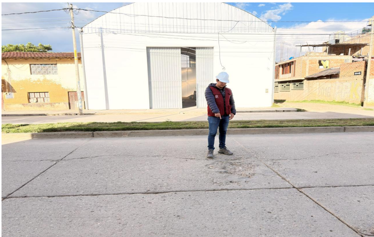
Figura 175. Falla (37) – Grieta de Retracción tomada en campo
