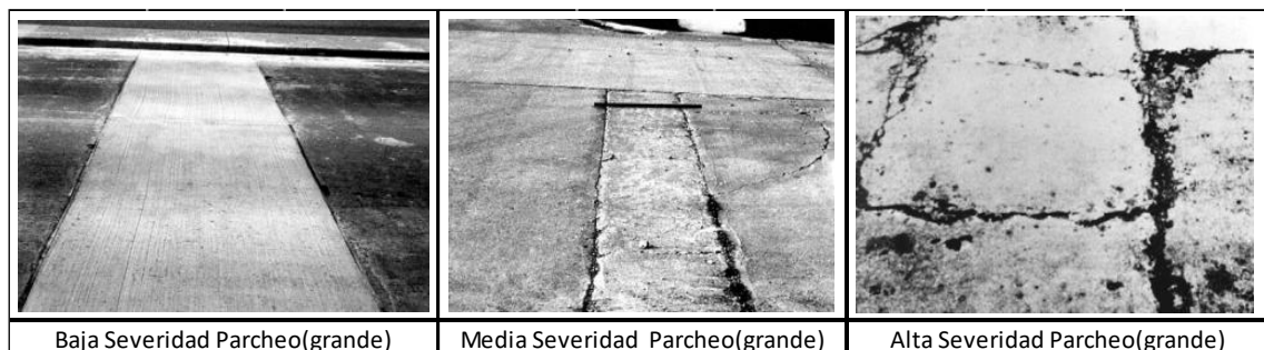
Figura 12. Nivel de severidad del parcheo grande
