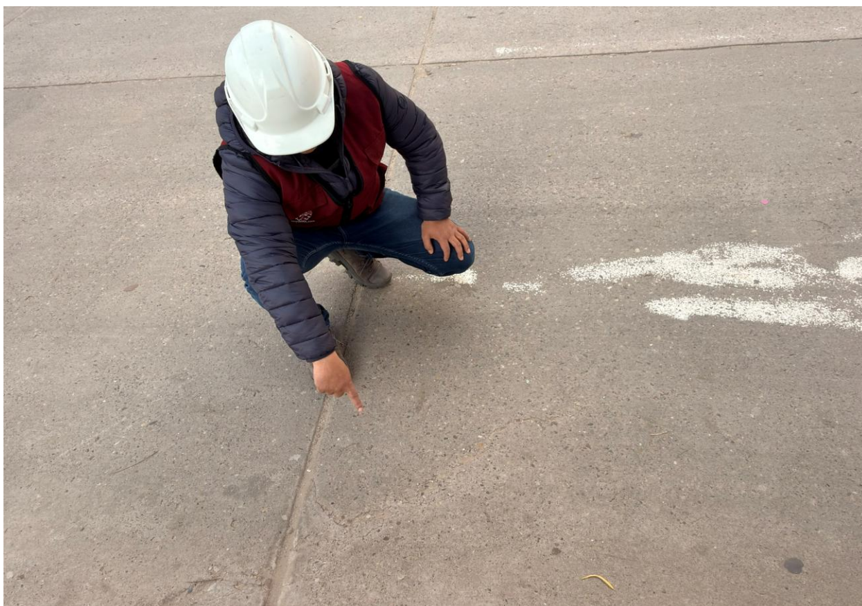
Figura 175. Falla (37) – Grieta de Retracción tomada en campo
