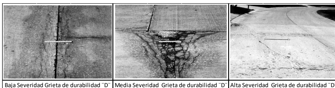
Figura 7. Nivel de Severidad de la grieta de durabilidad "D"
