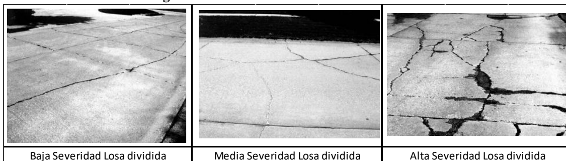
Figura 6. Nivel de Severidad de las losas divididas
