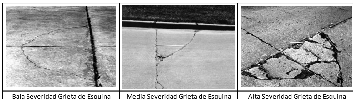
Figura 5. Nivel de Severidad de la grieta de esquina
