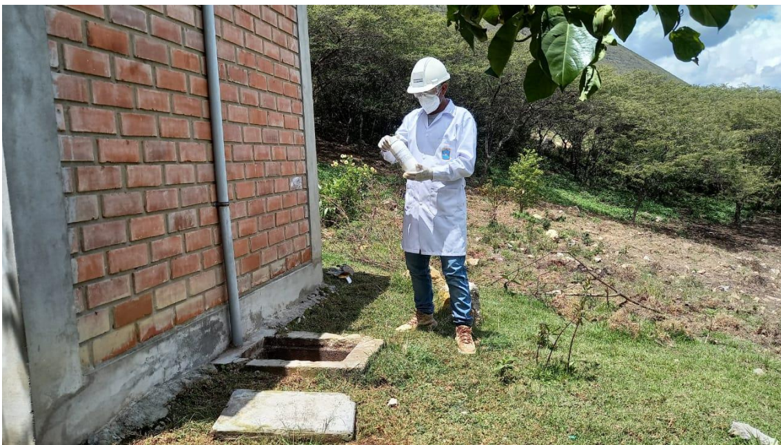
Figura 28. Caja de registro de la UBS, donde se realizará la toma de muestras del afluente.
