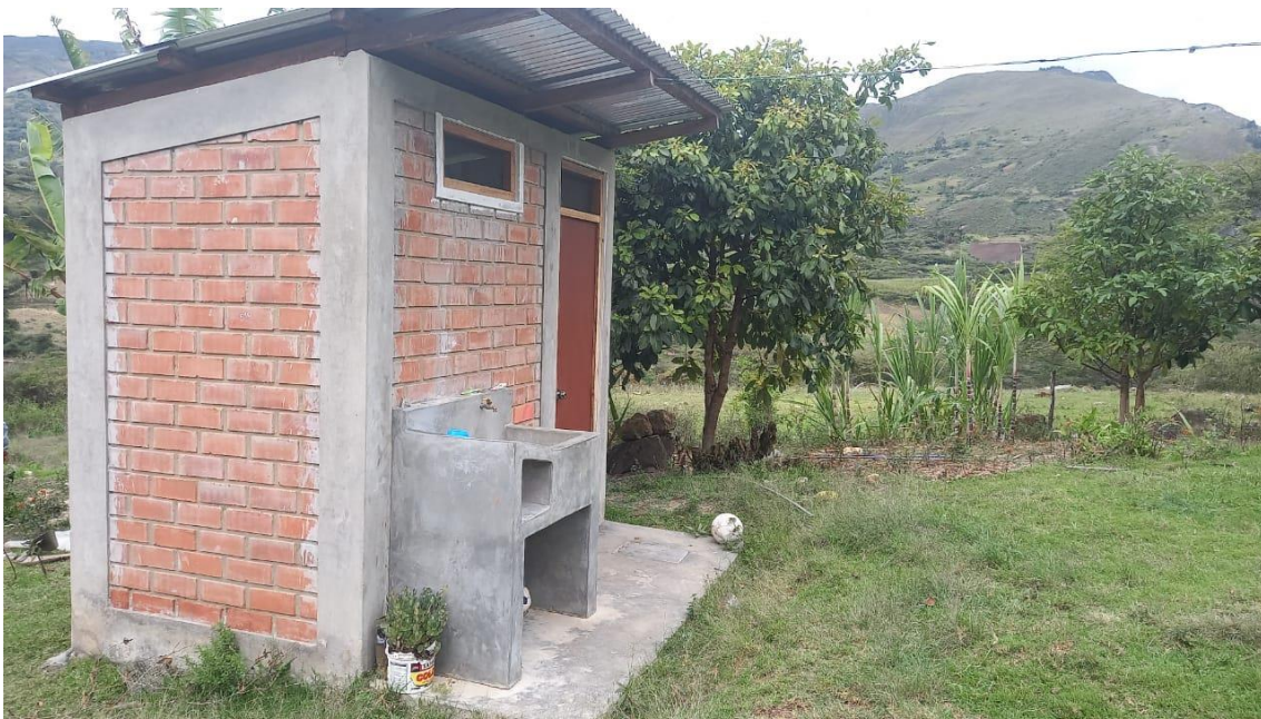
Figura N° 27. Unidad Básica de Saneamiento (UBS) ubicada a 1757 m.s.n.m donde estará ubicado el punto de monitoreo BP1.
