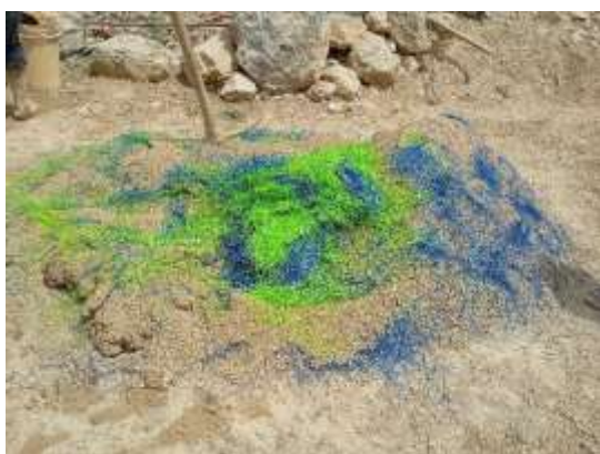
Figura 67. Preparación barro + Nylon
