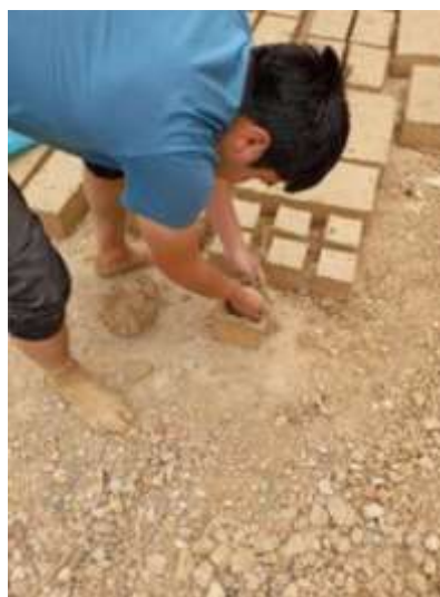
Figura 28. Preparación de adobes 10x10x10
