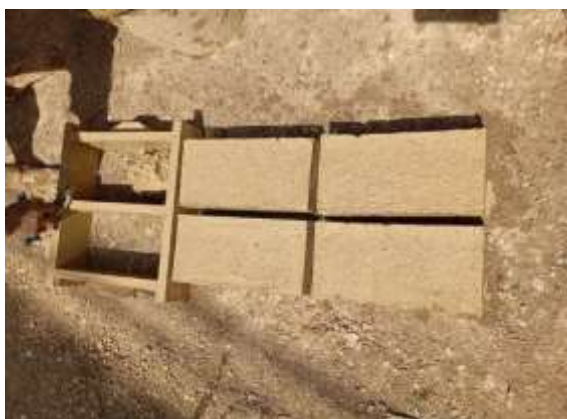
Figura 29. Preparación de adobes 40x20x10.
