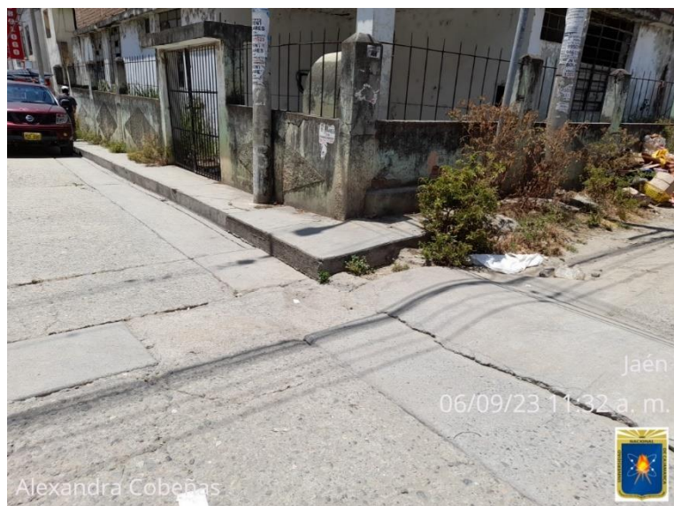
Figura 35: Intersección de las calles Huamantanga y Cajamarca, manzana N° 25
