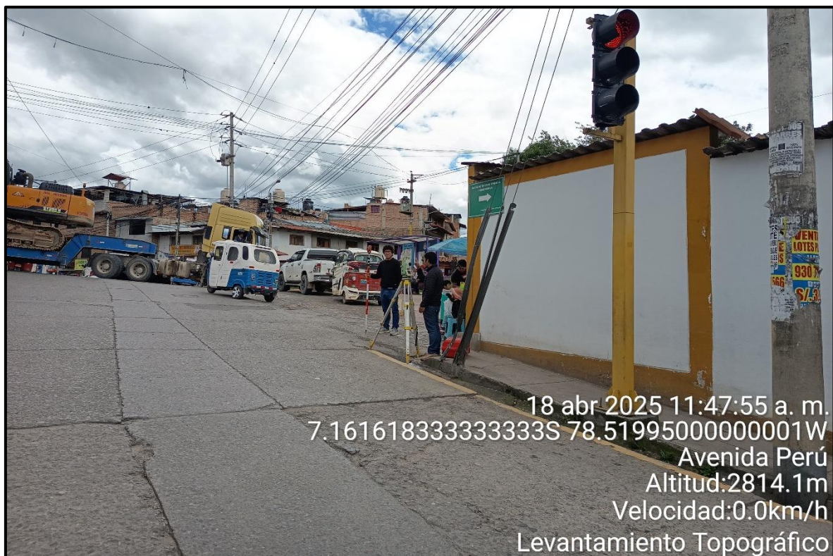
Fotografía N°3: Levantamiento topográfico con estación total en intersección semaforizada.
