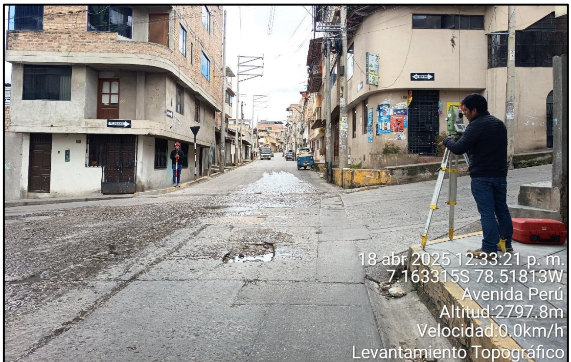
Fotografía N°2: Levantamiento topográfico con estación total jr. Cinco Esquinas
