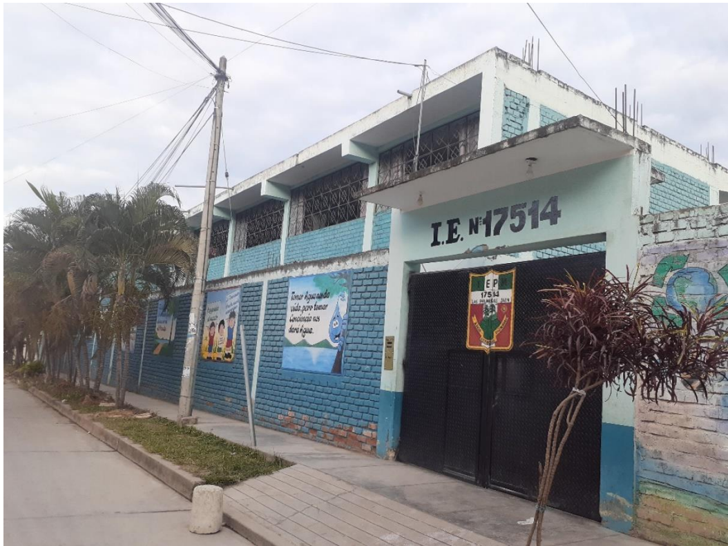
Fotografía N° 1. Fachada principal de la Institución Educativa N° 17514 Las Palmeras
