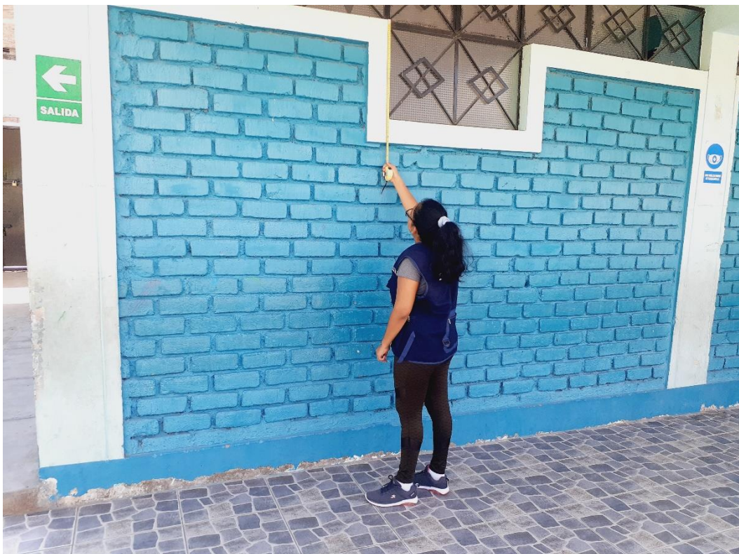
Fotografía N° 8. Se realizó las respectivas medidas para los planos arquitectónico.
