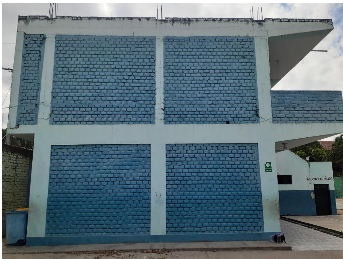
Fotografía N° 5. Vista lateral del bloque I de la Institución Educativa N° 17514
