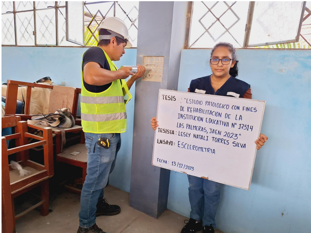
Fotografía N° 23. Se aprecia el Ensayo de Esclerometría – Muestra de la columna interior en el segundo nivel (bloque 02) entre el eje11-11 y eje A-A.
