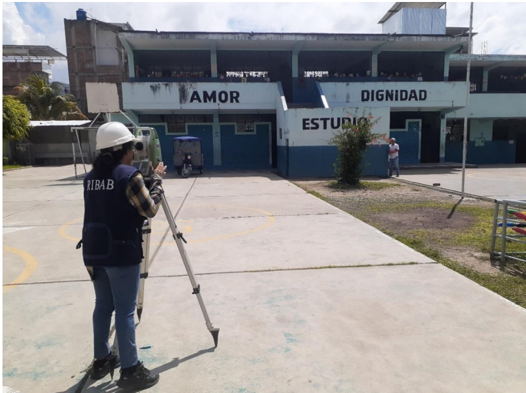
Fotografía N° 7. Se muestra el levantamiento topográfico con la ESTACIÓN TOTAL TOPOCON MODELO ES-105 en la Institución Educativa N° 17514 Las Palmeras.
