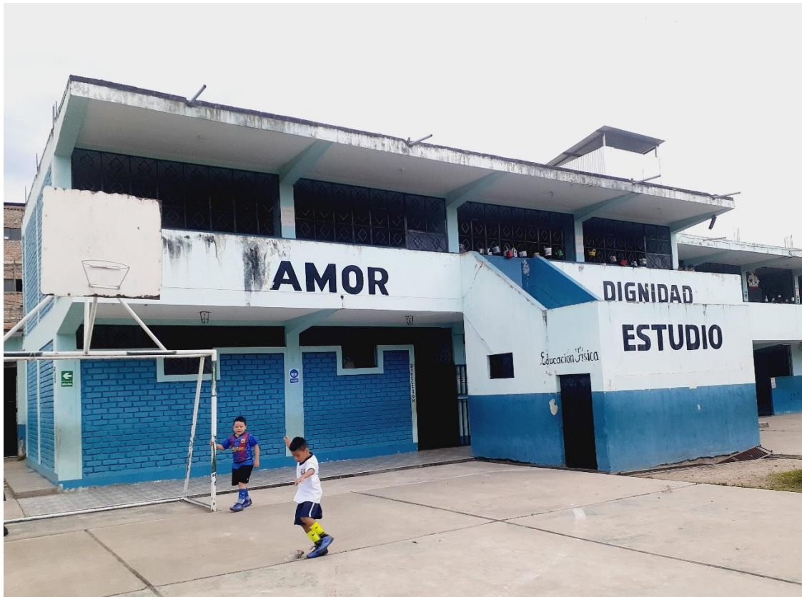
Fotografía N° 3. Vista de frente del bloque I de la Institución Educativa N° 17514.
